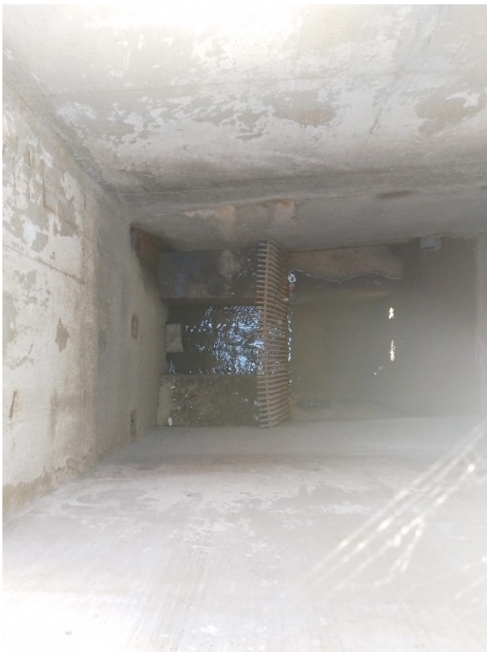
Figura 6. Gradeamento de entrada da EEEB.
