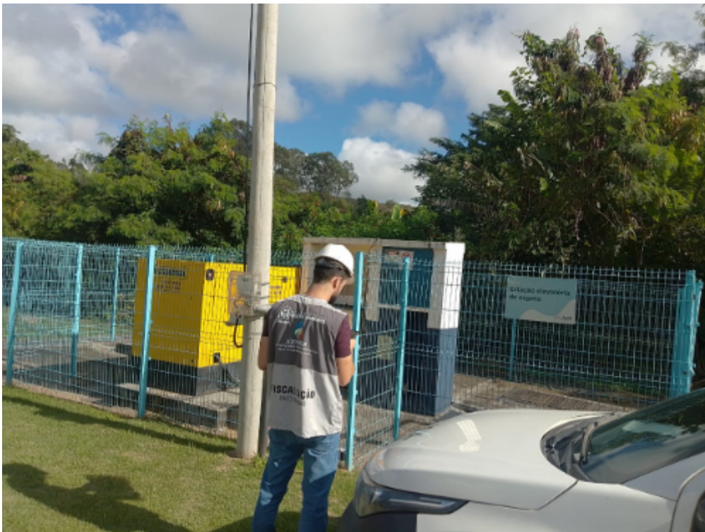
Figura 1. Identificação e cercamento da EEEB 1A.
