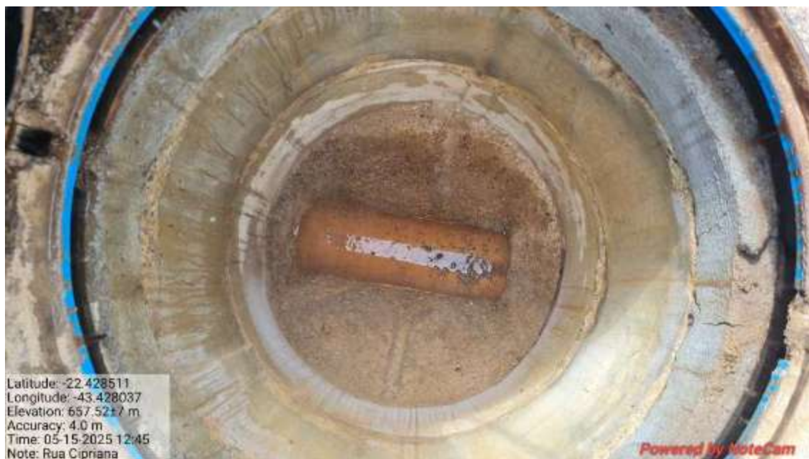
Figura 10. Poço de Visita (PV) com rede coletora na Rua Cipriana Soares.
