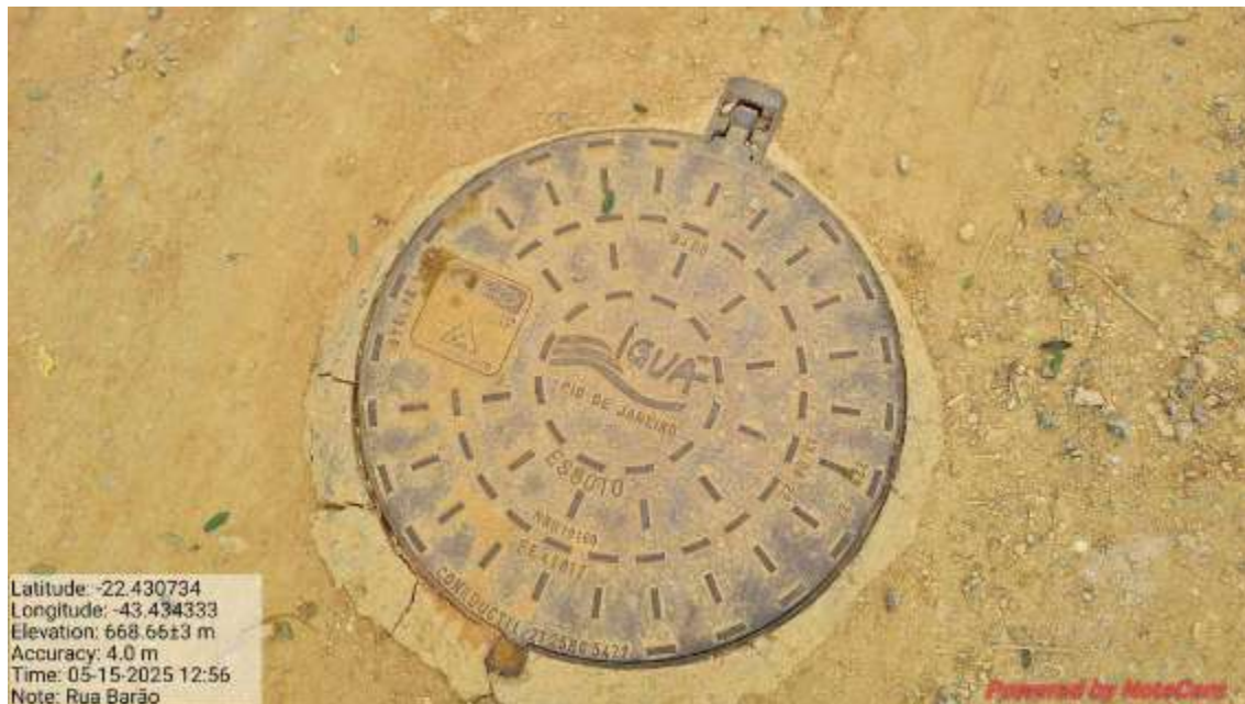
Figura 12. Poço de Visita (PV) de rede coletora na Rua Barão de Pati de Alferes.
