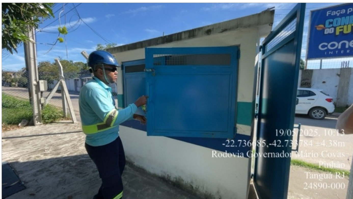
Foto 2 – Abrigo de alvenaria da elevatória.
