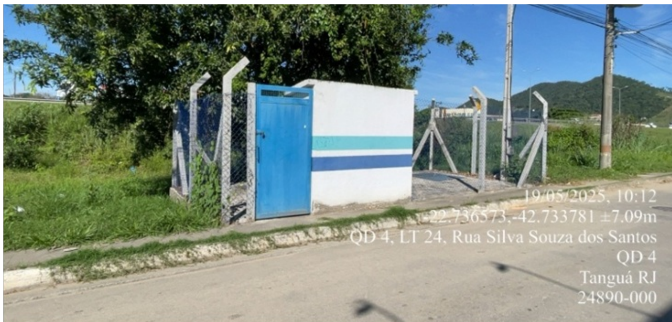
Foto 1 – Calçada onde está situada a EEBB.
