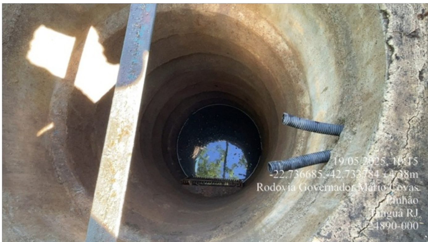
Foto 6 – POÇO DA CHEGADA DO ESGOTO.
