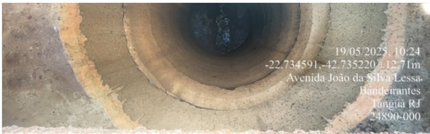
Foto 4 – Poço da chegada do esgoto
