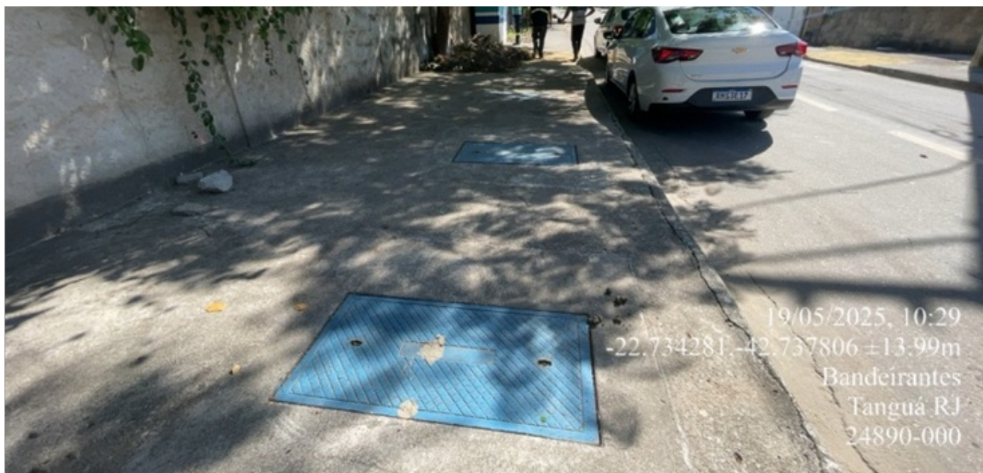
Foto 1 – Calçada onde está situada a EEEB.
