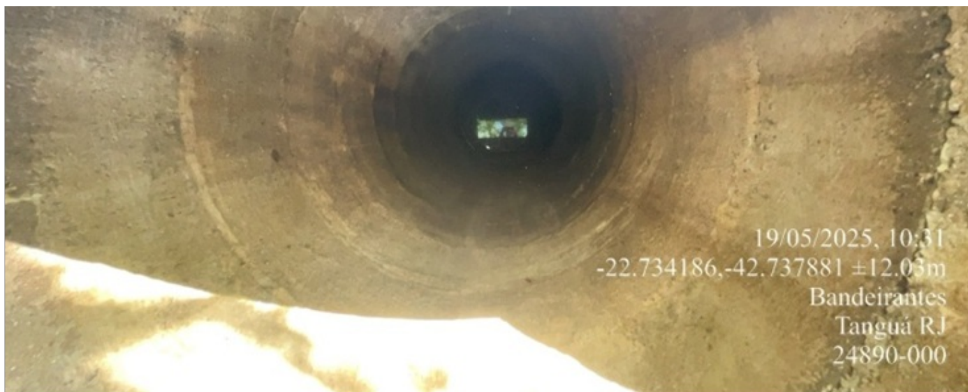
Foto 5 – Poço da chegada do esgoto.
