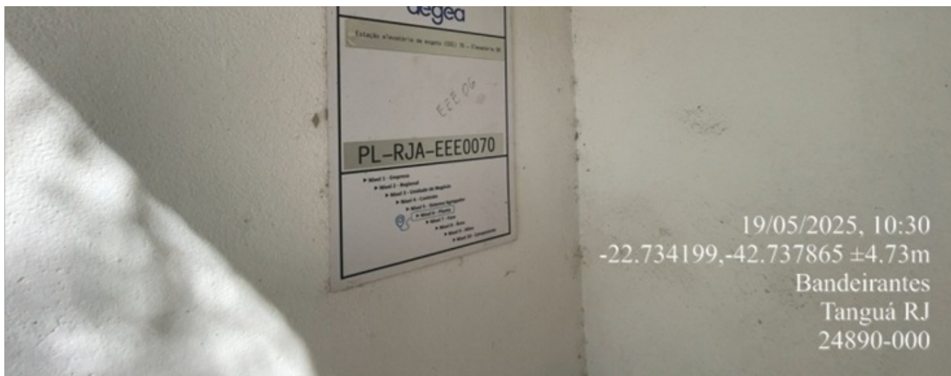
Foto 3 – Placa de identificação da elevatória.
