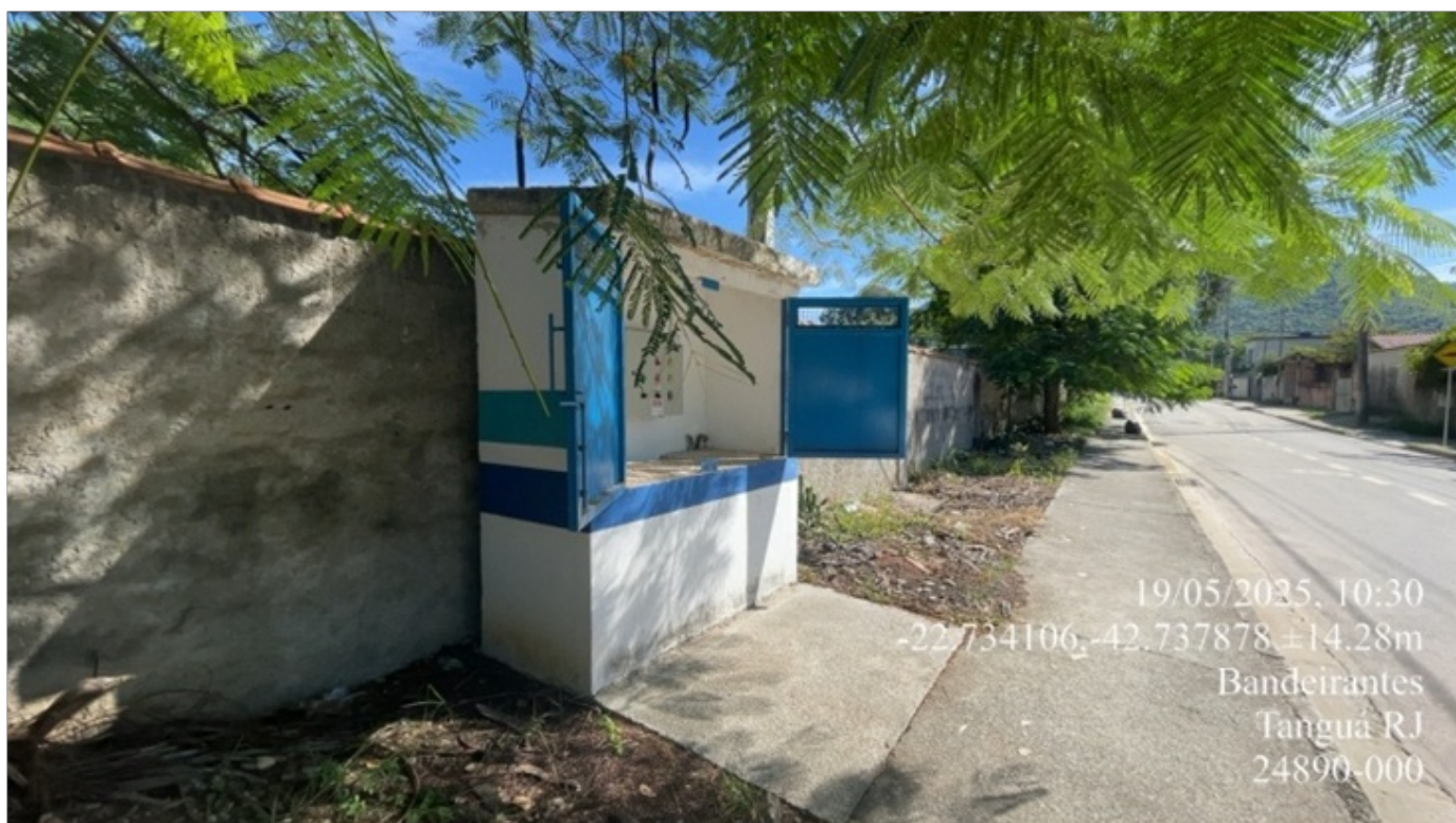
Foto 2 – Abrigo de alvenaria da elevatória.
