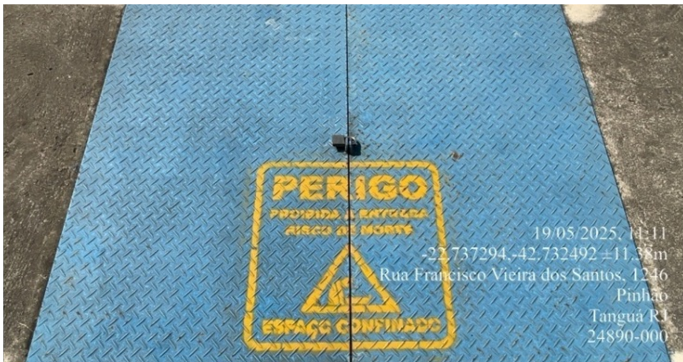
Foto 7 – Tamba de acesso ao poço possui fechamento
