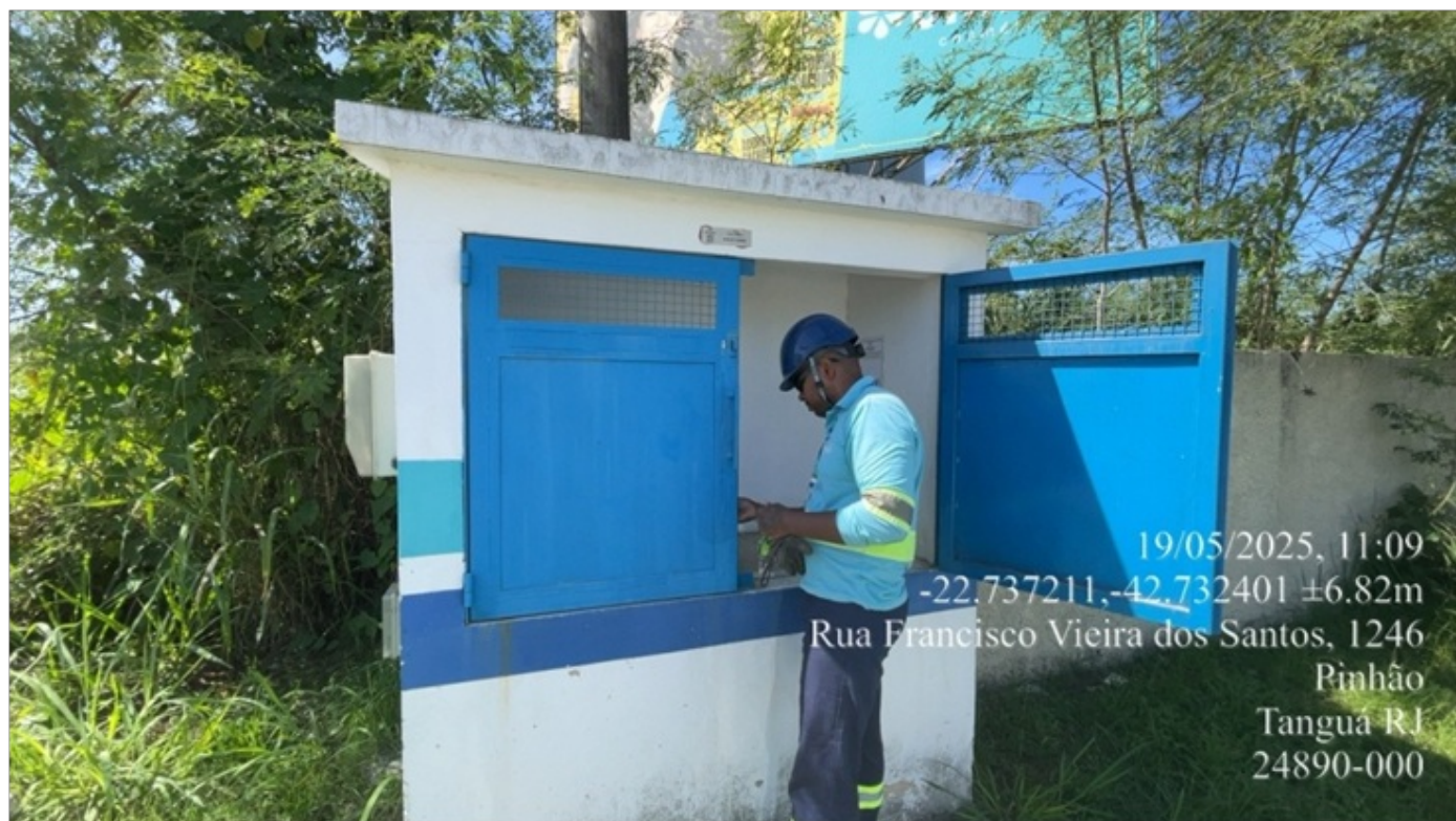
Foto 2 – Abrigo de alvenaria da elevatória.
