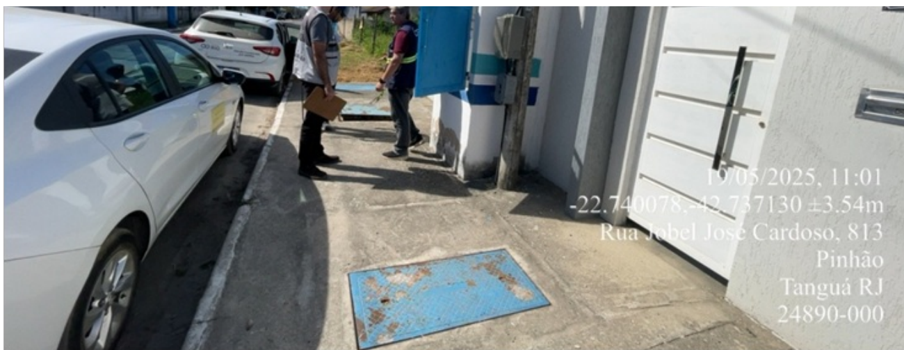
Foto 1 – Calçada onde está situada a EEEB.
