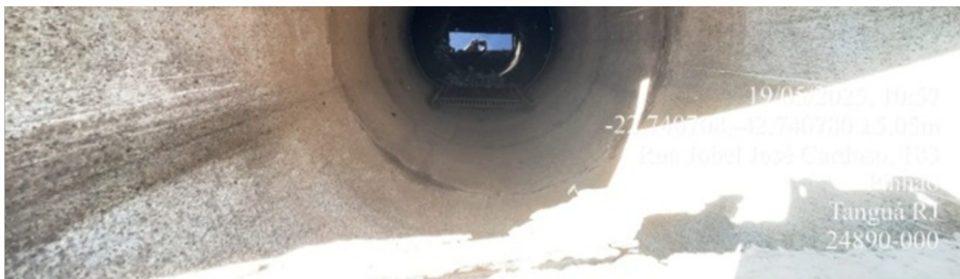
Foto 4 – Poço da chegada do esgoto
