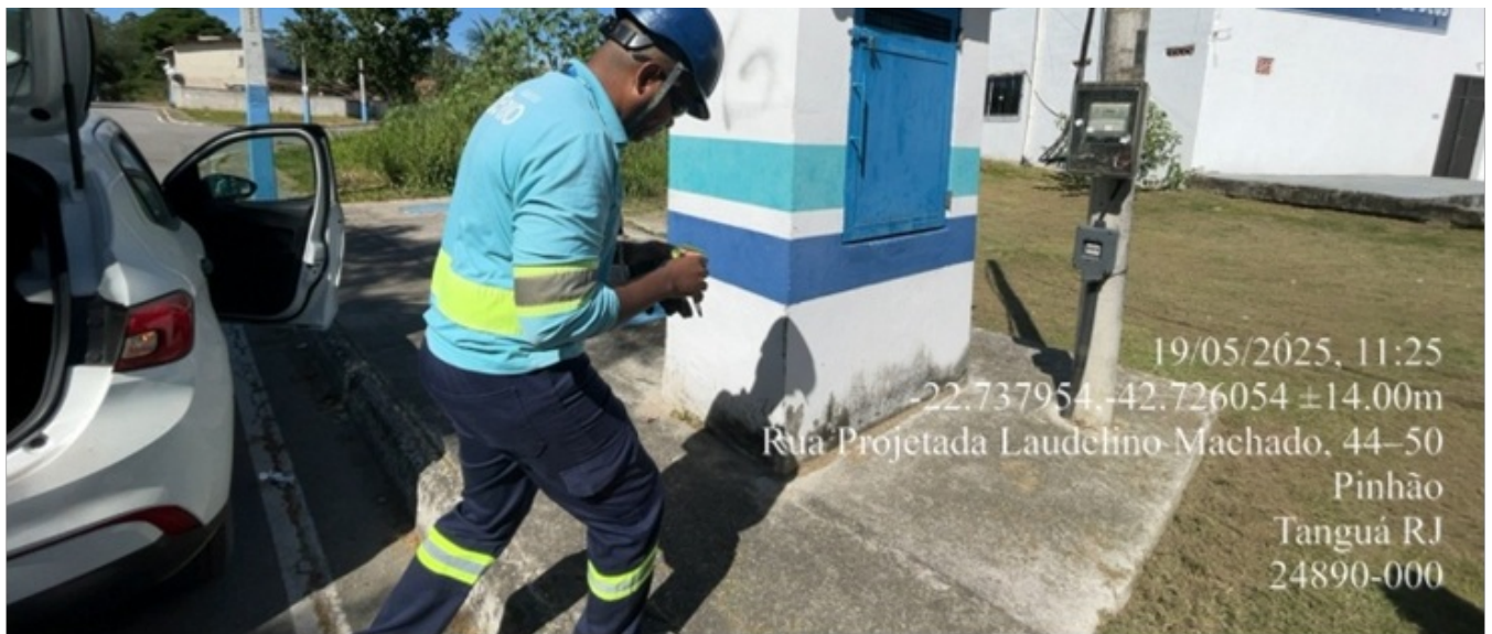
Foto 1 – Abrigo da EEEB.
