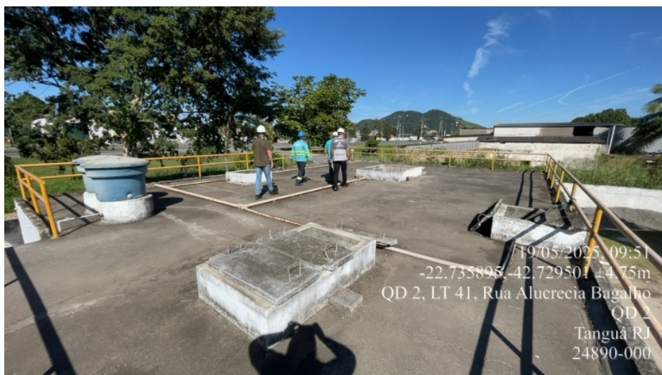
Foto 04: Vista parcial da ETE.
