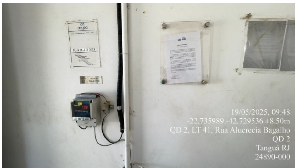
Foto 11: Instalação do monitoramento de vazão afluente.
