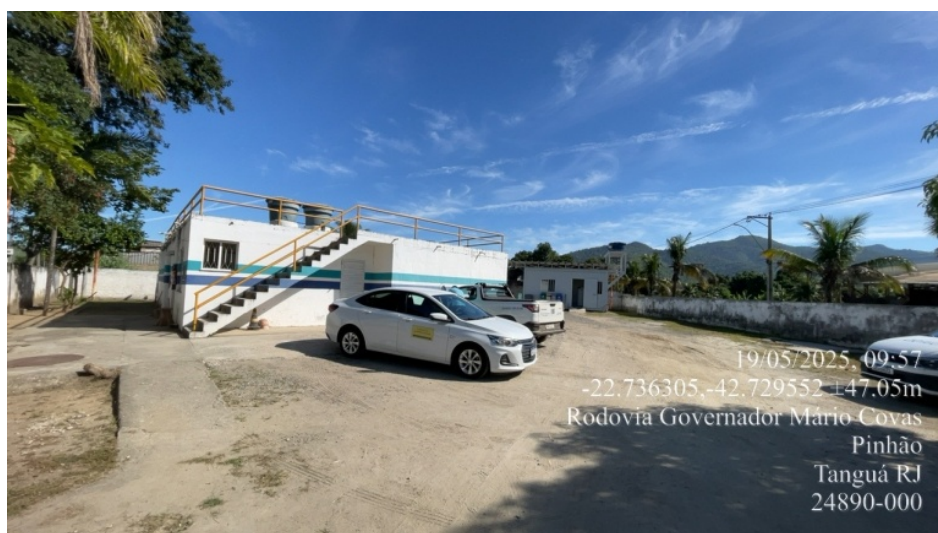
Foto 16: Vista parcial da ETE.
