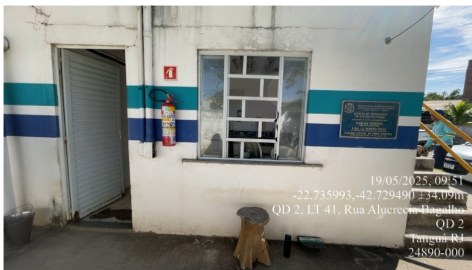
Foto 15: Sala administrativa e laboratório.
