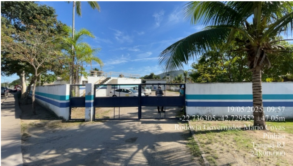
Foto 01: Entrada da ETE (ausência de identificação).
