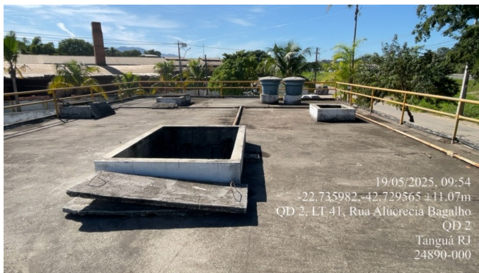
Foto 05: Vista parcial da ETE.
