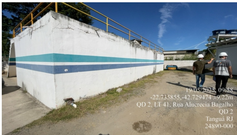
Foto 17: Vista Parcial da ETE.
