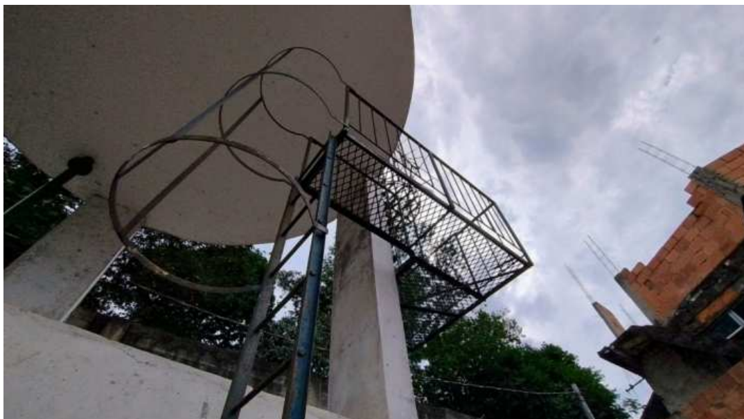
Foto 04: Escada de acesso ao reservatório.
