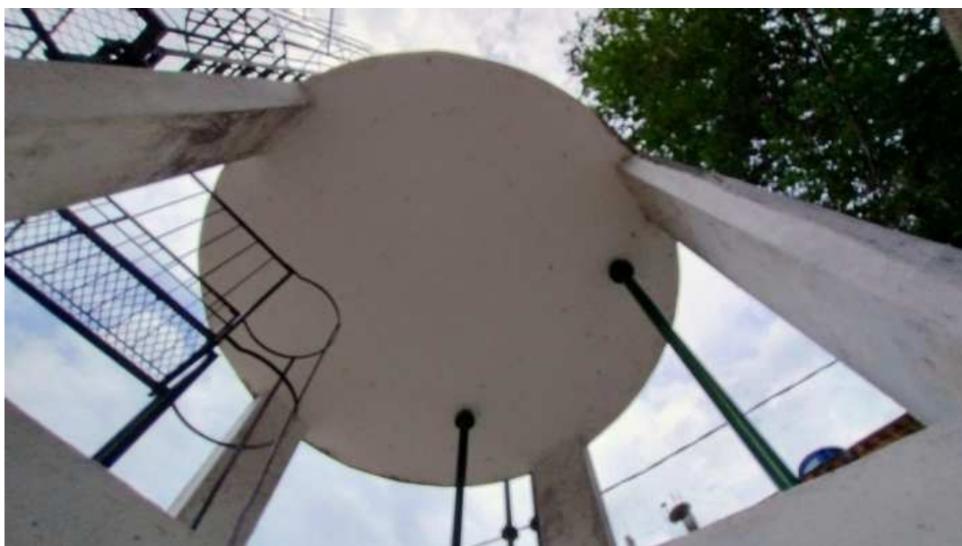
Foto 05: Vista do fundo do reservatório.
