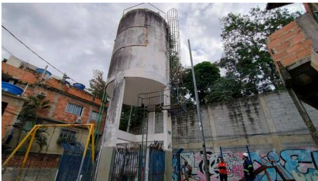
Foto 02: Vista do reservatório.
