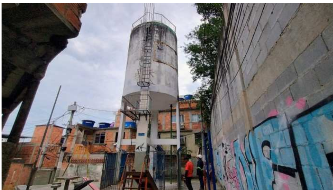
Foto 01: Vista do reservatório.
