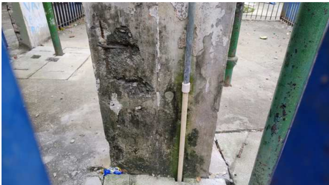
Foto 09: Pilar do reservatório.
