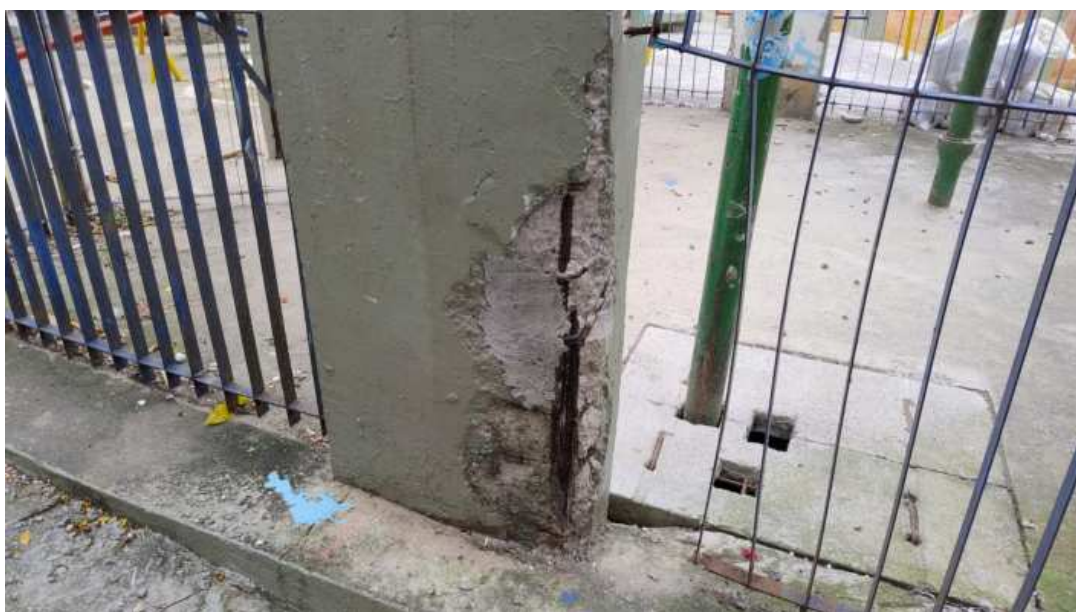
Foto 10: Pilar do reservatório.
