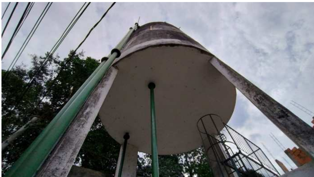
Foto 07: Vista do reservatório.
