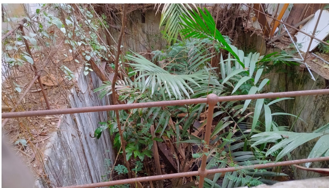
Foto 06: Vista da Escada de Acesso
