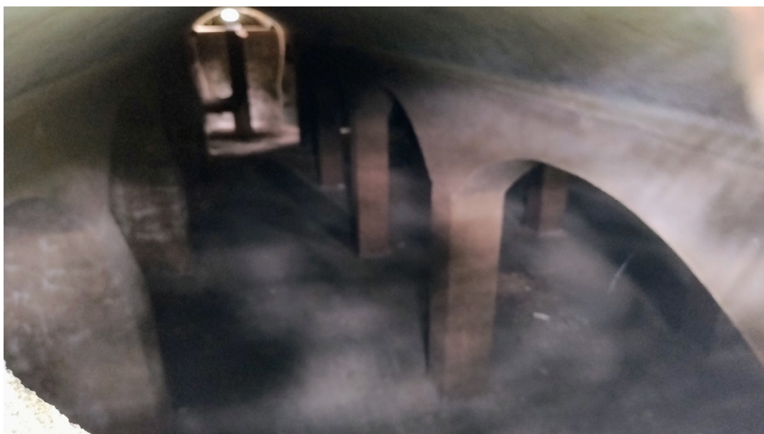
Foto 04: Vista interna do reservatório.
