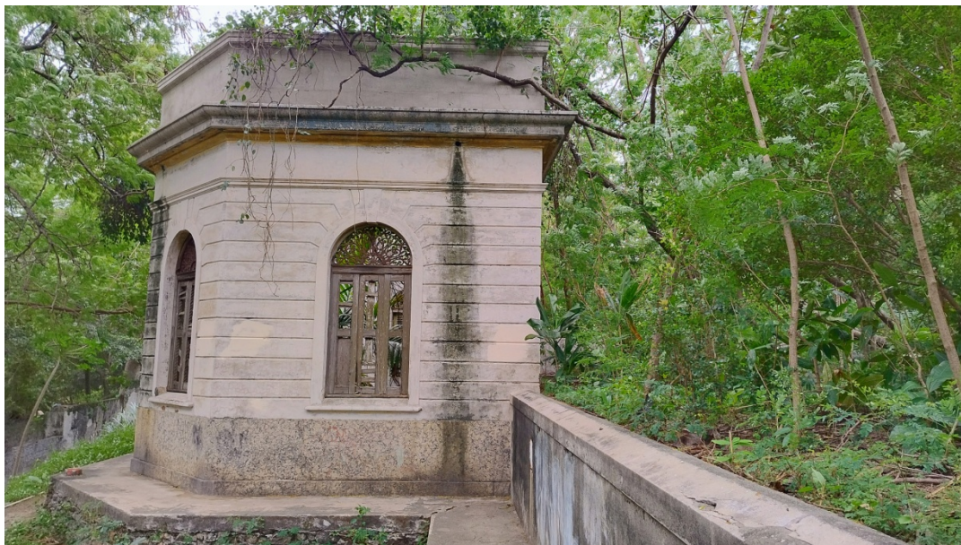
Foto 03: Vista do reservatório.
