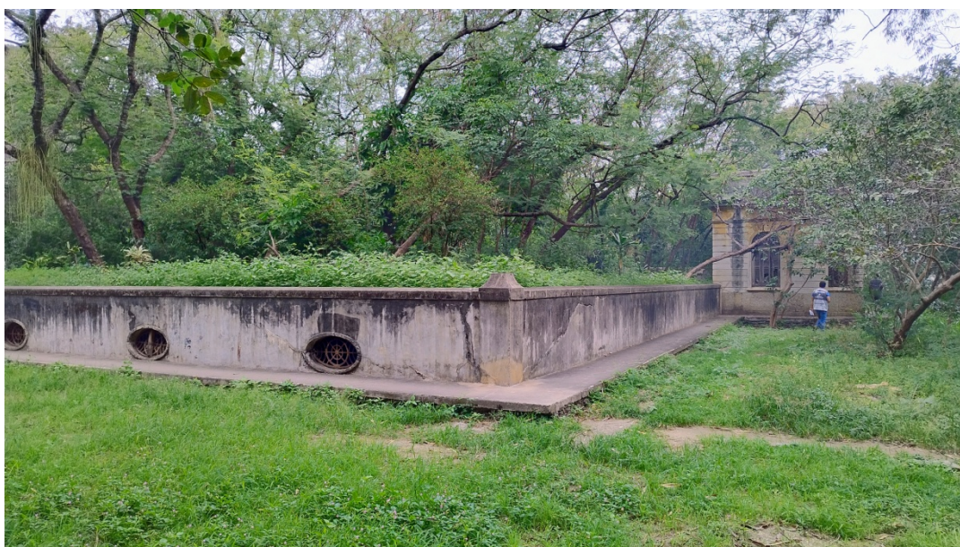
Foto 02: Vista do reservatório.
