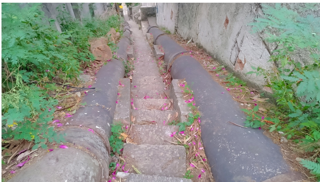
Foto 01: Escada de acesso ao terreno do reservatório.
