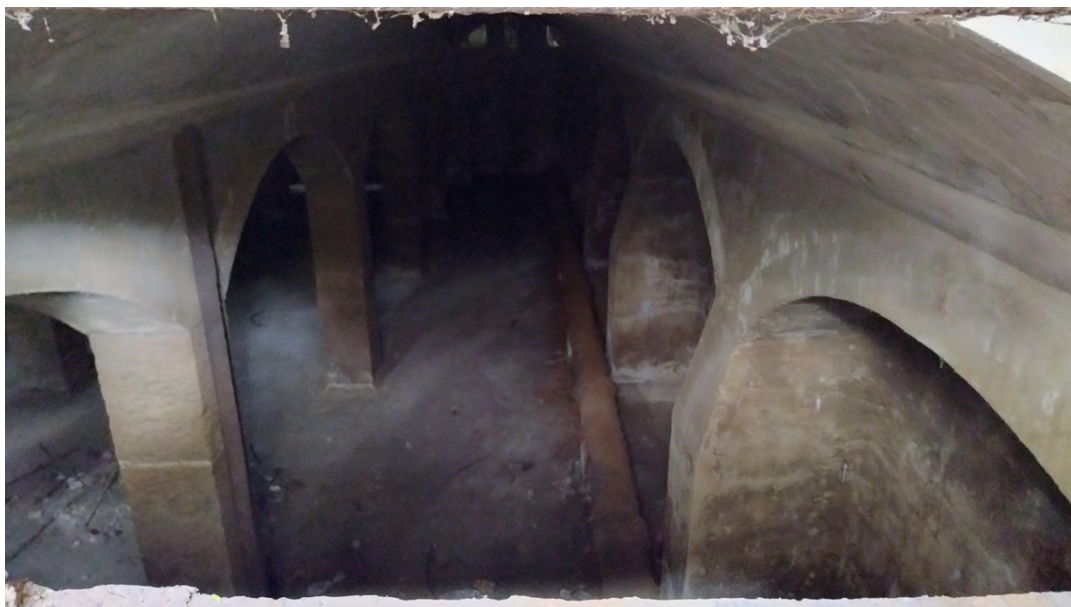
Foto 05: Vista interna do reservatório.
