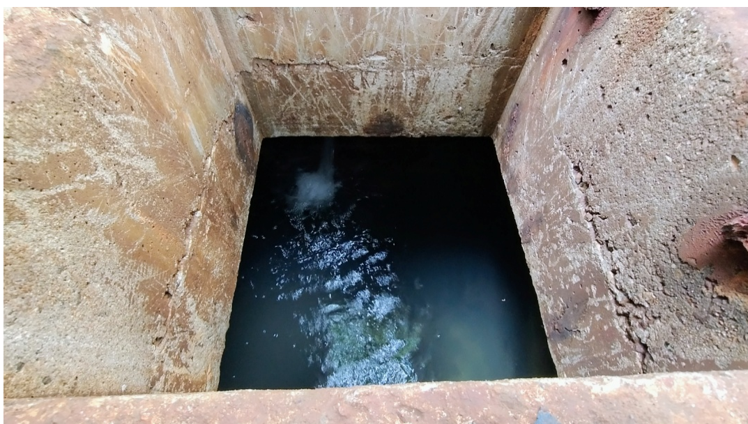
Foto 04: O reservatório estava sendo abastecimento no momento da fiscalização.
