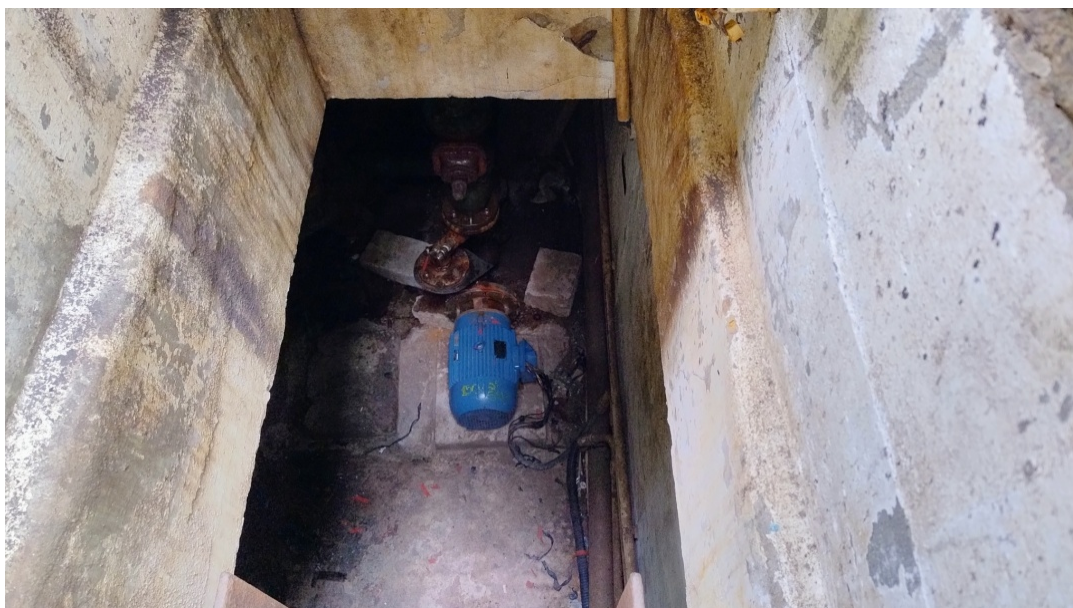
Foto 02: Casa de bomba do reservatório.
