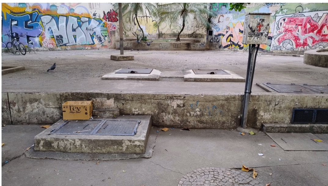
Foto 01: Vista da área do reservatório.
