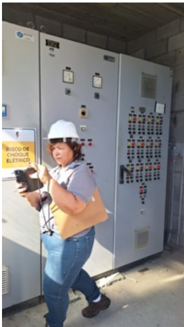
Foto 11 e 12 – Quadro elétrico com inversores de frequência colocados externamente, provavelmente em melhoria operacional.
