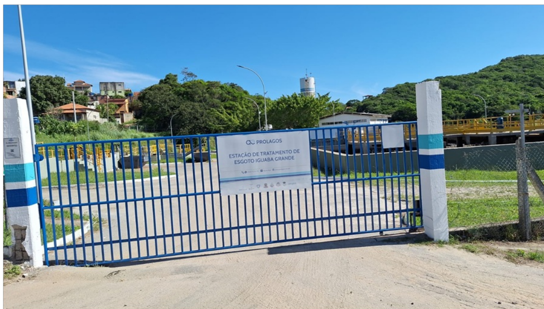
Foto 2 –Vista da entrada da ETE.
