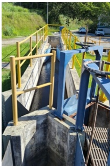
Foto 9 e 10 – Calha Parchall e sensor para medição automática por telemetria.
