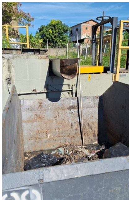
Foto 6 – Resíduos retidos no gradeamento fino são conduzidos manualmente para caçamba e enviados para aterro sanitário.
