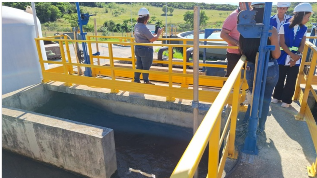
Foto 13 – Elevatória de esgoto bruto e recirculação de lodo do decantador.
