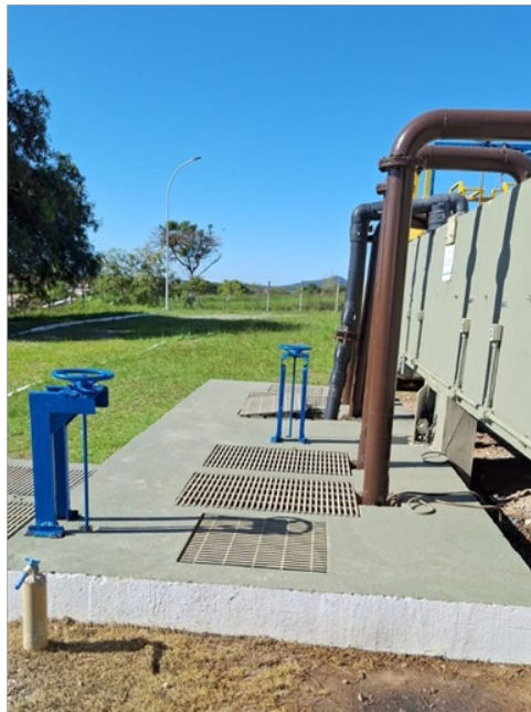
Foto 13 – Elevatória de esgoto bruto e recirculação de lodo do decantador.
