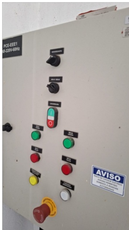
Fotos 3 – Quadro com sistema visual de operação e controle para operação manual e automática.
