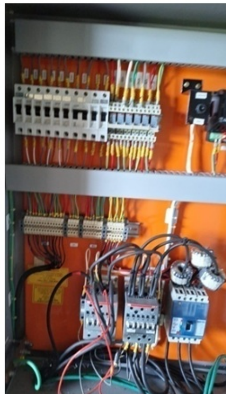
Fotos 3 – Quadro com sistema visual de operação e controle para operação manual e automática.
