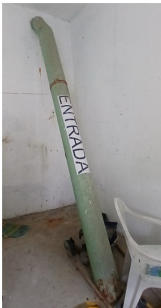
Foto 16 – Tubulação de recalque
