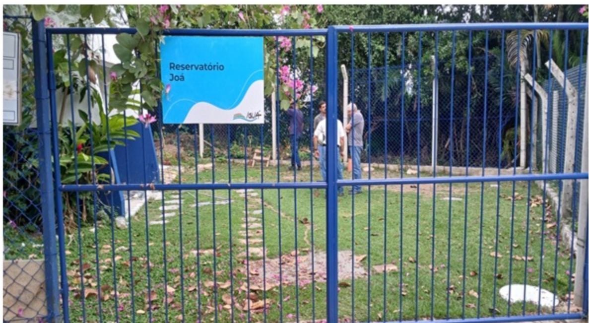
Foto 2 – Identificação do reservatório
