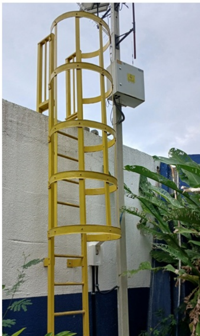
Foto 6 – Escada externa com proteção
