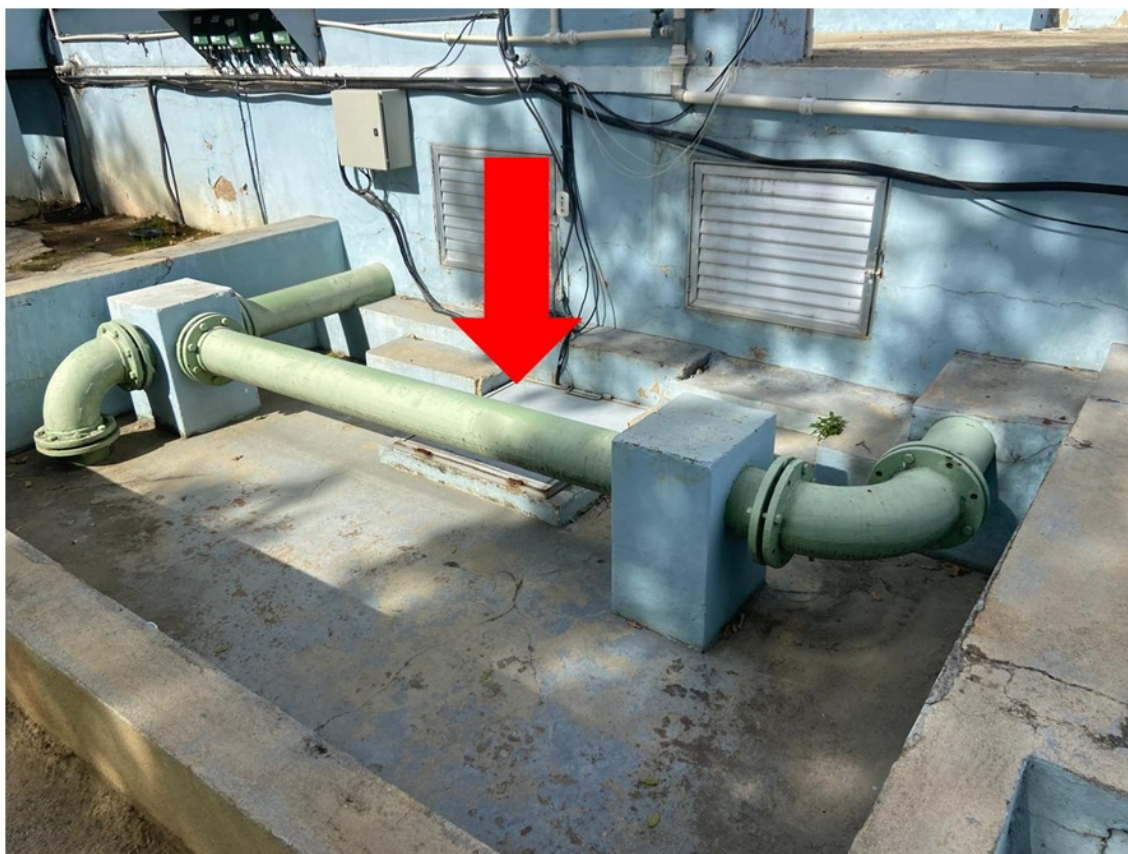
Foto 4 – Tubulações e conexões do extravasor em bom estado de conservação.
