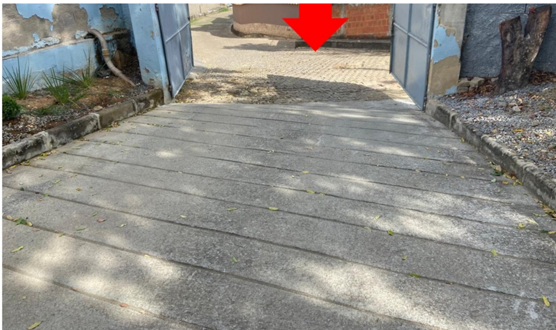
Foto 3 – Estrada de acesso ao reservatório em bom estado de conservação.
