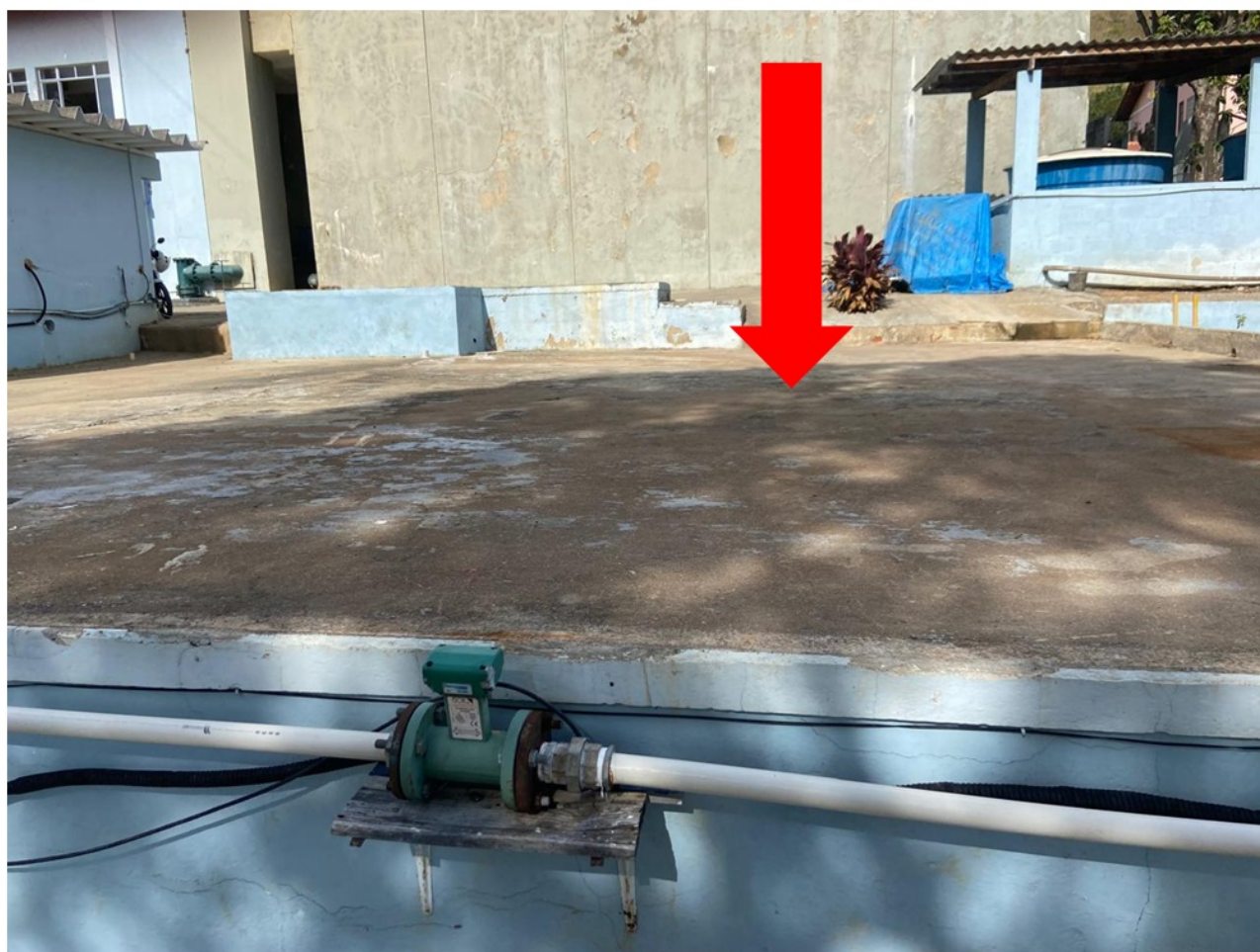
Foto 2 – Cobertura feita de concreto armado em bom estado de conservação.
