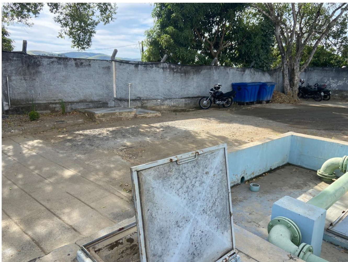
Foto 7 – Reservatório no pátio da ETA isolado por muro.
