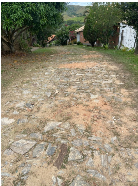
Foto 3 – Estrada de acesso ao reservatório em bom estado de conservação.
