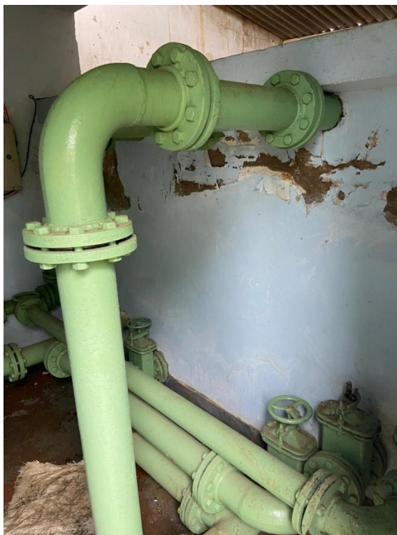
Foto 04 – Tubulações de entrada, saída e extravasor em bom estado de conservação.
