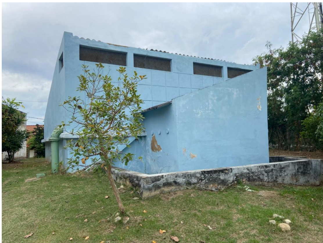
Foto 1 – Reservatório sem identificação e nenhum tipo de cercamento
