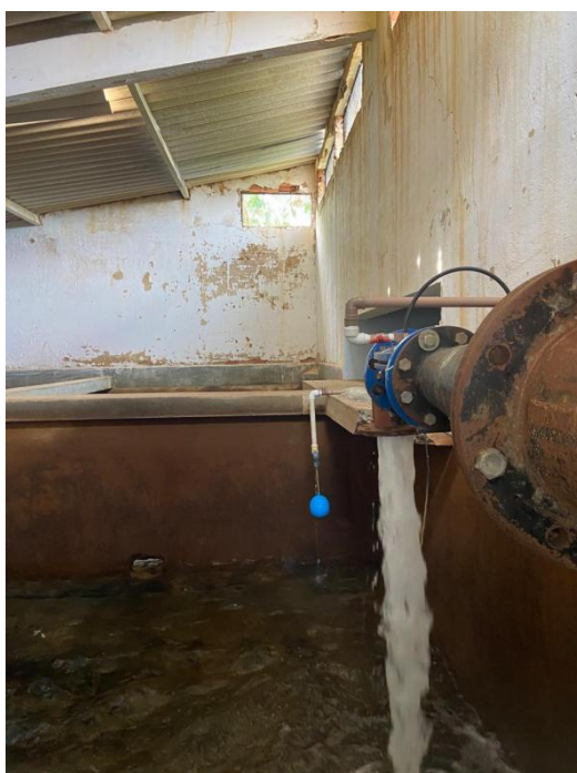
Foto 05 – Interior do reservatório com cobertura de telha amianto.
