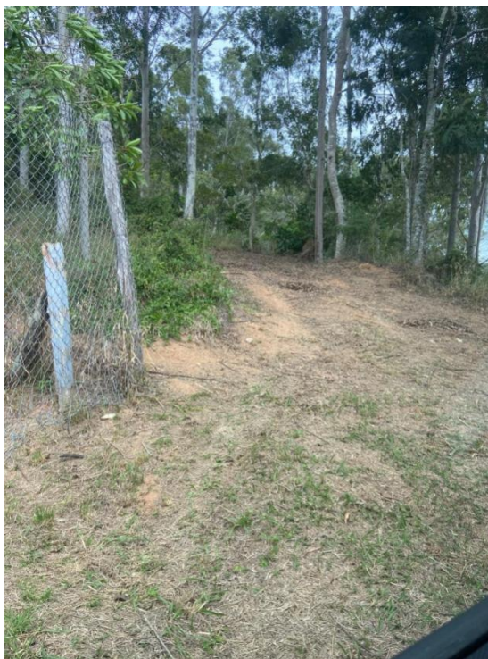
Foto 4 – Estrada de acesso ao Reservatório necessita de melhorias.
