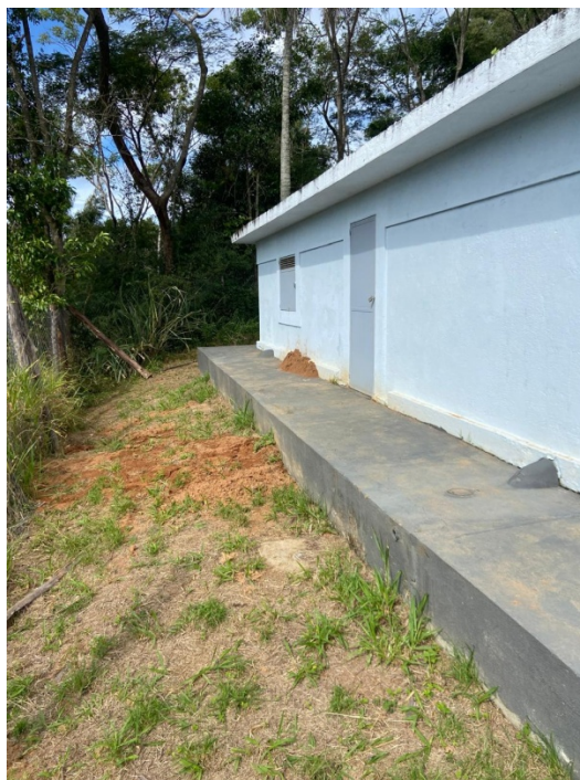
Foto 3 – Área externa do reservatório em bom estado de conservação.
