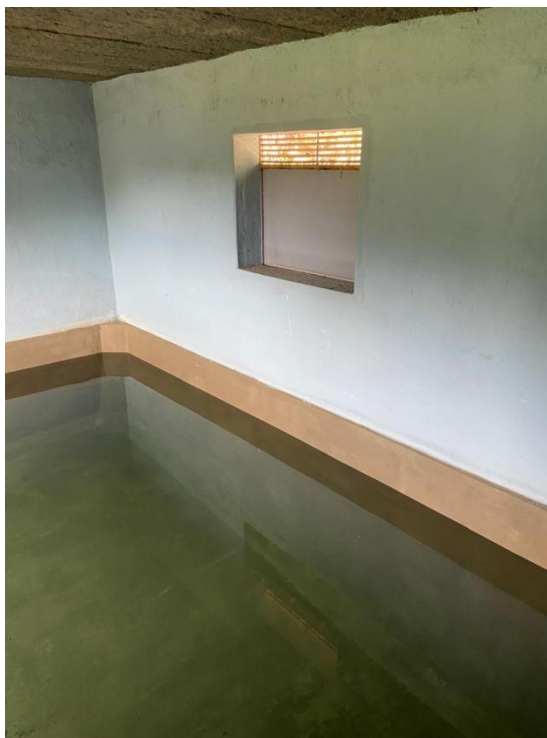
Foto 4 – Interior do reservatório. Em bom estado de conservação.
