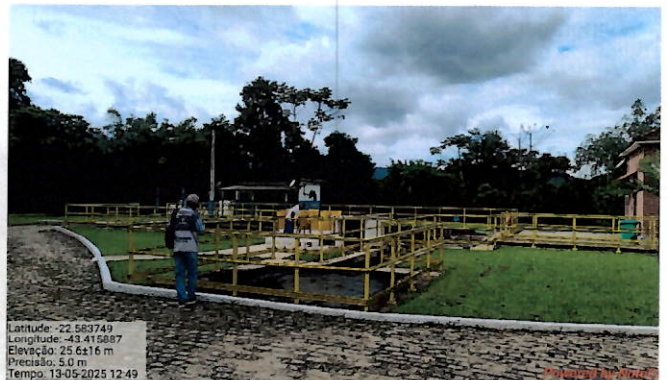
Foto 29: Vista da unidade de tratamento.
