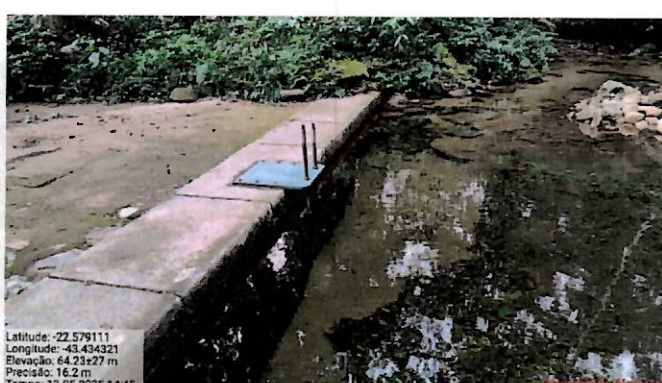
Foto 11: Represa de Macuco (comporta instalada).
