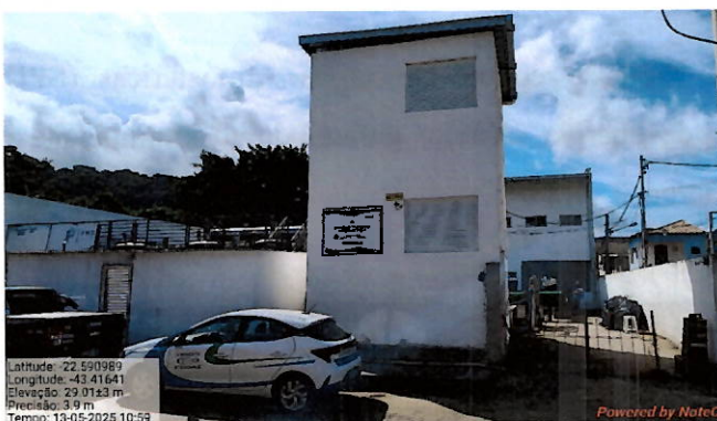
Foto 41: Fachada da ETA (ausência de muro).
