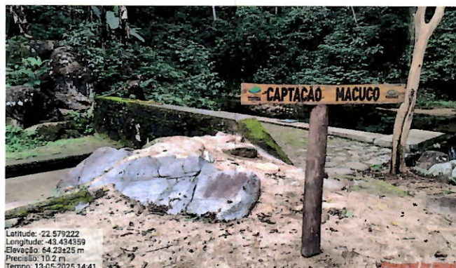
Foto 9: Placa de identificação da captação.
