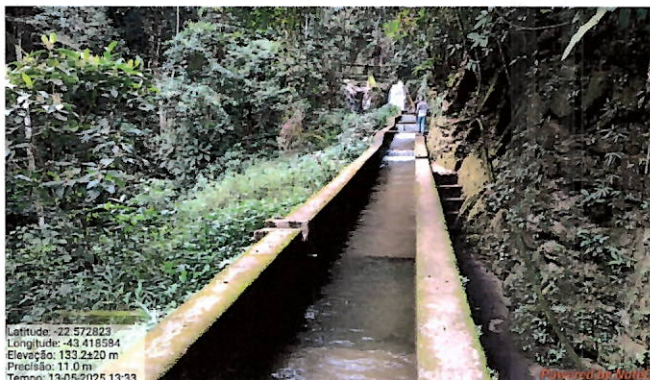
Foto 4: Canal de transporte de água.
