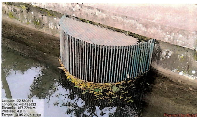
Foto 18: grades substituídas.
