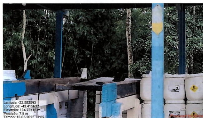
Foto 36: Armazenamento de Hipoclorito de Cálcio.
