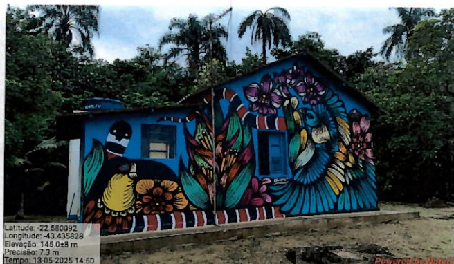
Foto 21: Posto dos operadores restaurado.
