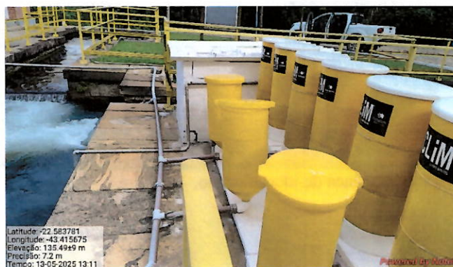
Foto 35: Sistema de desinfecção com Hipoclorito de Cálcio.
