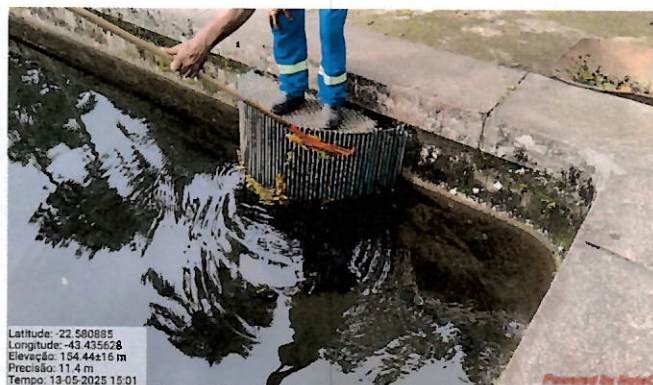
Foto 19: Limpeza das grades.
