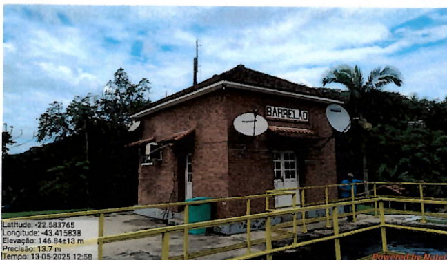
Foto 30: Vista da unidade de tratamento.
