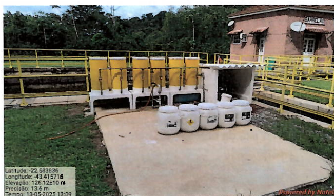
Foto 34: Sistema de desinfecção com Hipoclorito de Cálcio.
