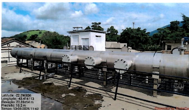
Foto 45: Área sobre o reservatório onde serão instalados os equipamentos de desinfecção por UV.
