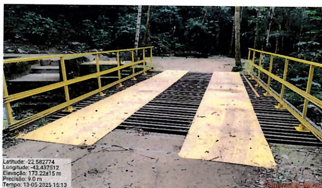
Foto 22: Ponte de acesso restaurada.
