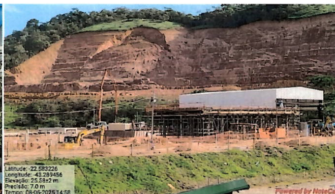
Foto 52: Vista da obra.
