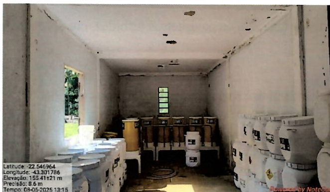
Foto 27: Sistema de desinfecção com hipoclorito de cálcio.
