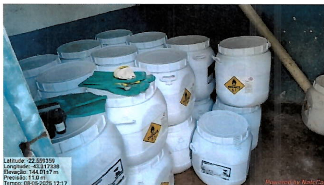
Foto 48: Armazenamento de hipoclorito de cálcio.
