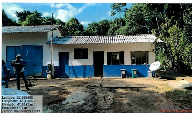
Foto 44: Prédio onde está localizado o laboratório.
