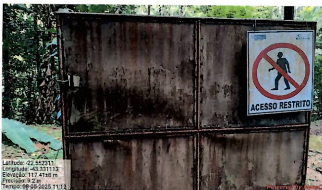
Foto 3: Portão de acesso à barragem com placa indicando acesso restrito.
