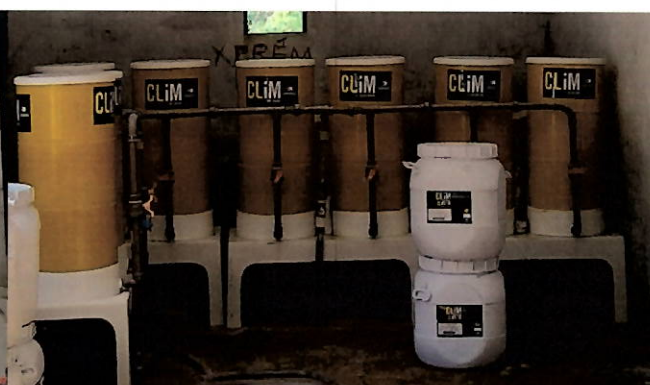
Foto 28: Sistema de desinfecção com hipoclorito de cálcio.
