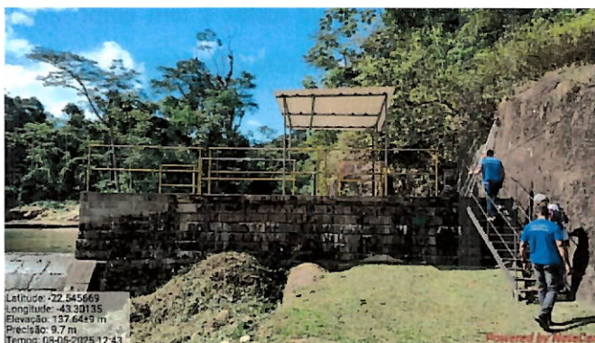
Foto 13: Acesso à barragem João Pinto.
