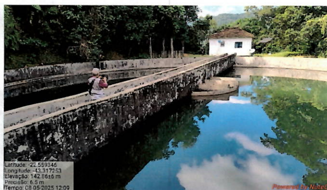
Foto 37: Tanque de decantação da UT Xerém II.
