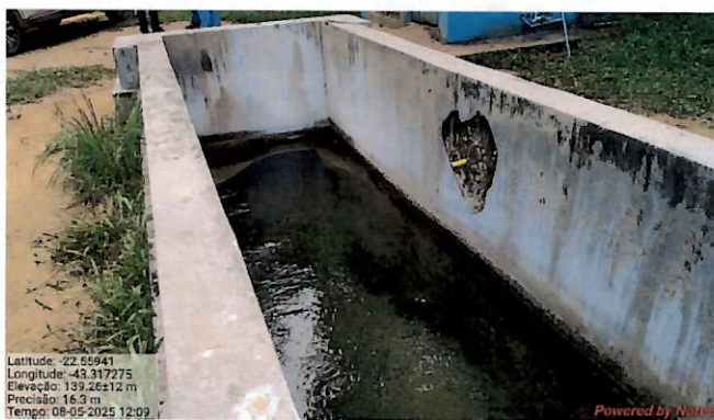
Foto 36: Entrada da água na UT Xerém II.
