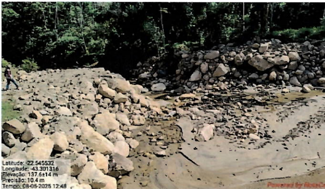
Foto 17: Material sedimentado depositado a jusante da barragem.
