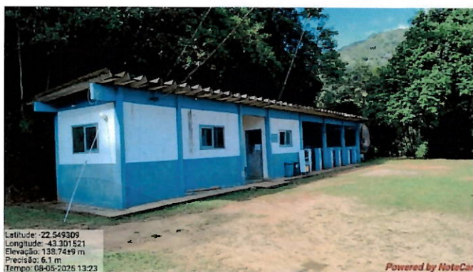
Foto 31: Prédio onde está localizado o laboratório.
