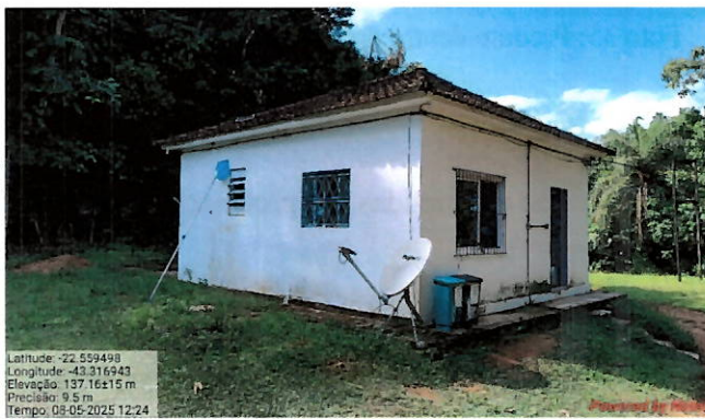
Foto 40: Abrigo para operadores da UT Xerém II.
