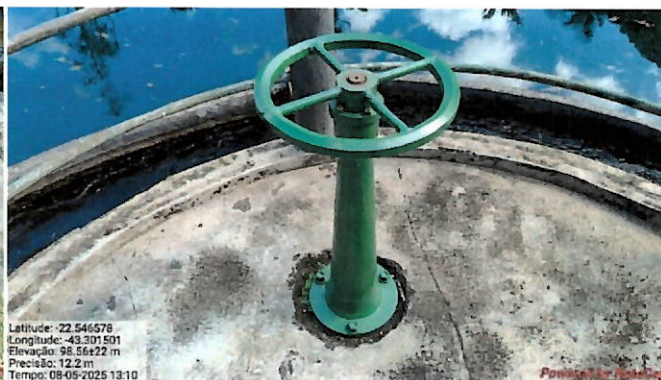
Foto 24: Volante do registro reparado.
