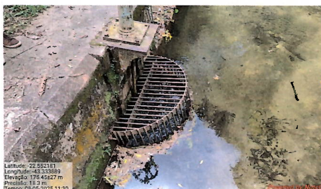
Foto 6: Gradeamento da captação da Barragem Paraíso (Registro).
