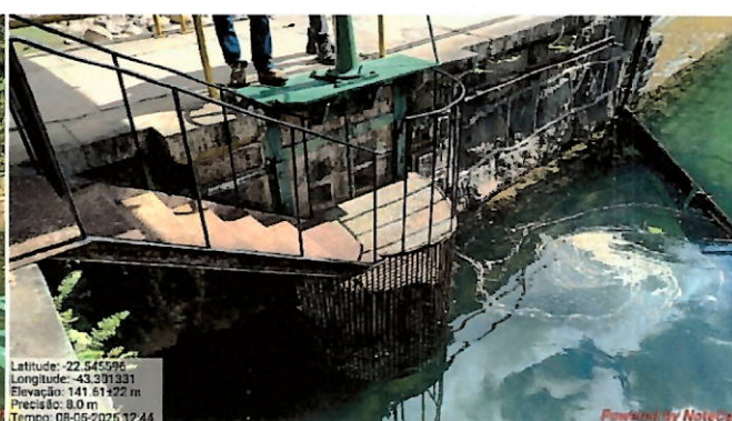
Foto 16: Comporta, gradeamento e escada de acesso (manutenção realizada).
