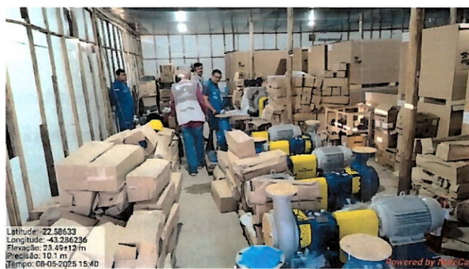
Foto 55: Interior do galpão.
