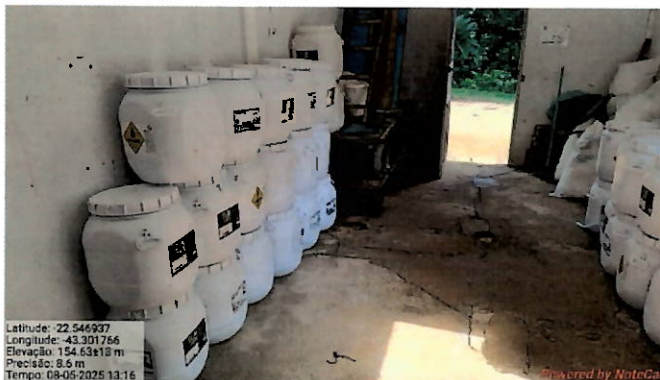
Foto 34: Armazenamento de hipoclorito de cálcio.
