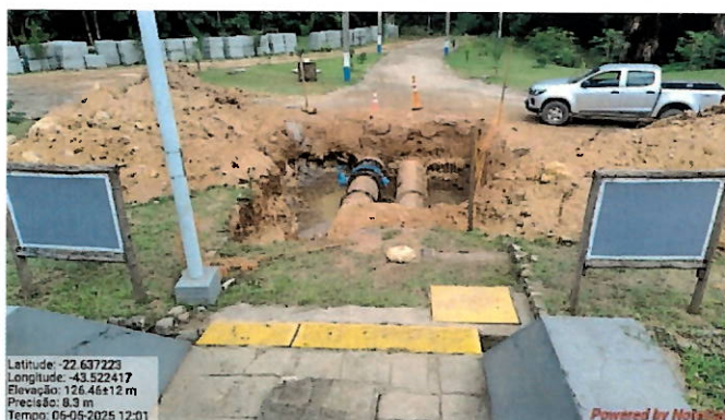
Foto 25: Instalação de registro em adutora de água tratada.
