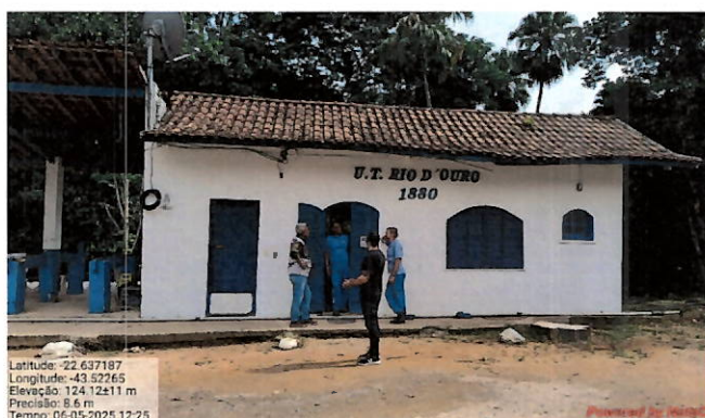
Foto 15: Vista externa da sala operacional e laboratório.
