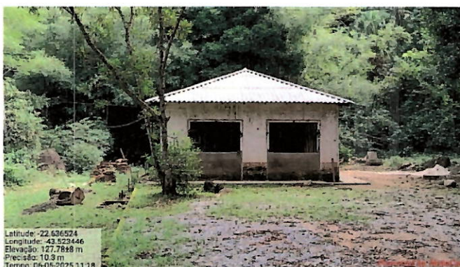
Foto 22: Obra do refeitório e vestiário.
