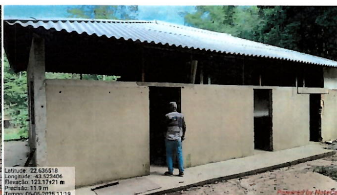
Foto 23: Obra do refeitório e vestiário.
