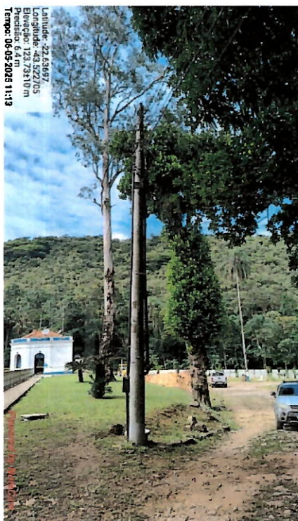
Foto 24: Rede elétrica instalada.
