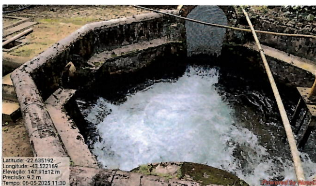
Foto 5: Encontros das águas provenientes das represas Rio D'Ouro e Santo Antônio.
