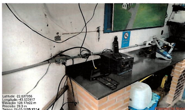
Foto 16: Equipamentos de comunicação utilizados pelos operadores.
