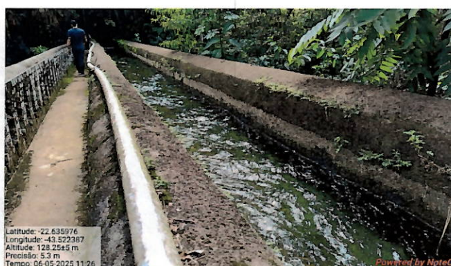
Foto 6: Canal de transporte de águas para o reservatório.
