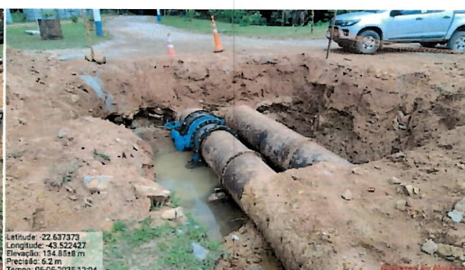
Foto 26: Instalação de registro em adutora de água tratada.
