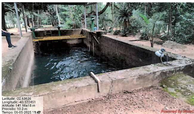
Foto 7: Tanque onde é realizada a pré-cloração.
