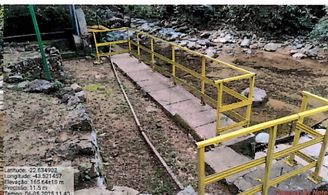
Foto 4: Guarda-corpo instalado.
