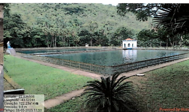
Foto 10: Reservatórios (8.175 m³ cada).
