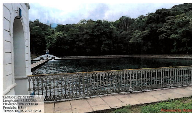
Foto 12: Cercamento dos reservatórios.
