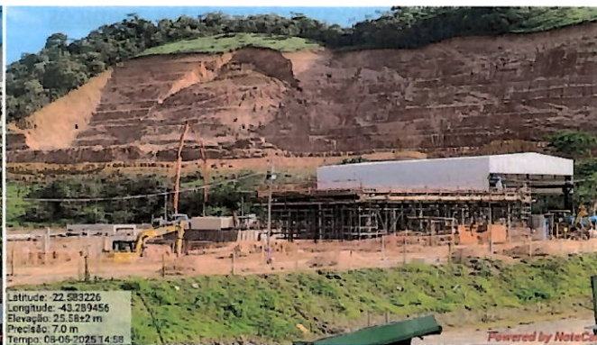
Foto 38: Vista da obra.
