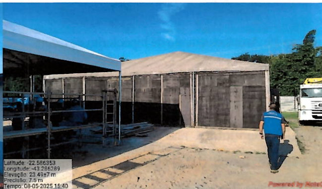
Foto 40: Galpão de armazenamento de equipamentos e membranas.
