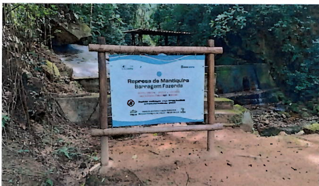
Foto 1: Barragem Fazenda (placa de identificação instalada).
