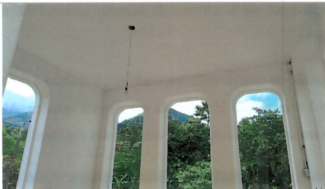
Foto 25: Interior da Casa de Química reformada.
