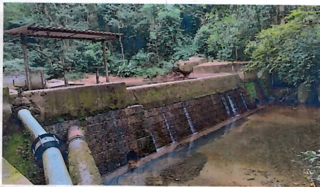
Foto 9: Barragem do Meio.
