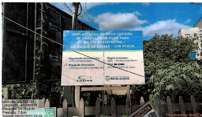
Foto 37: Placa da obra.
