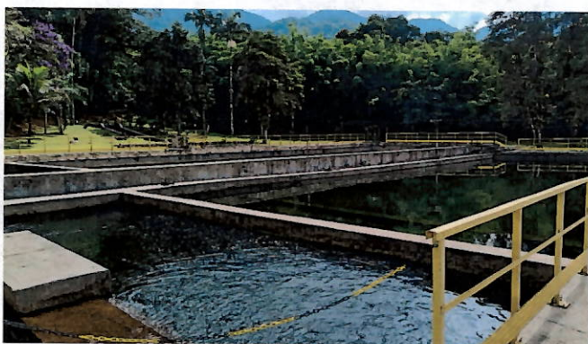
Foto 23: Decantador com guarda-corpo instalado.
