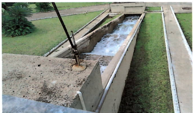
Foto 27: Escada hidráulica - saída de água do decantador.
