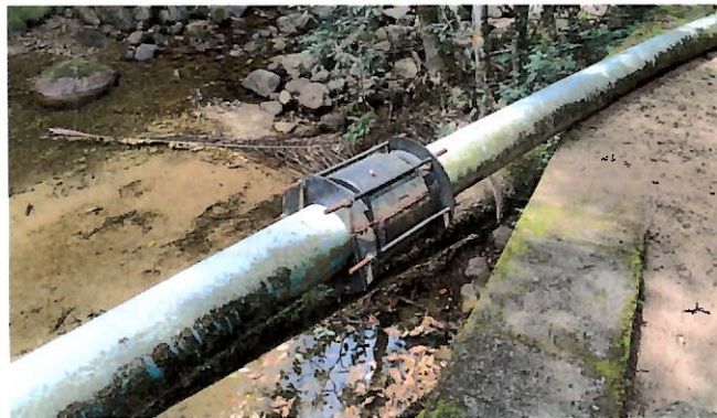
Foto 13: Reparo realizado em adutora (ausência de vazamento).
