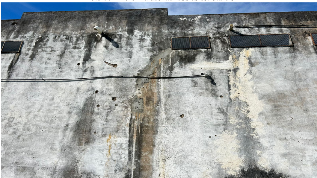
Foto 07 – Reforma das rachaduras estruturais
