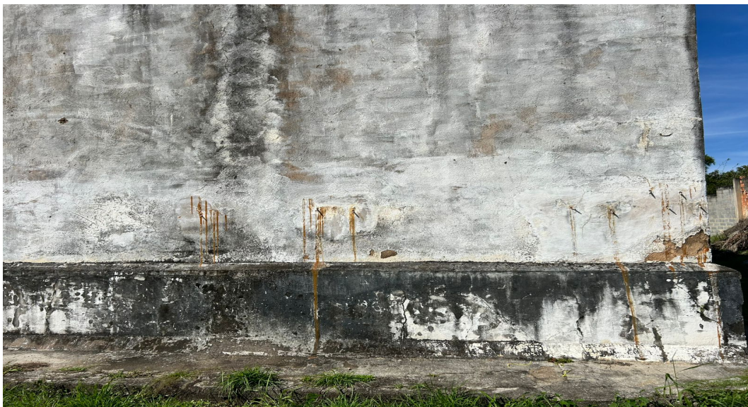
Foto 06 – Reforma das rachaduras estruturais
