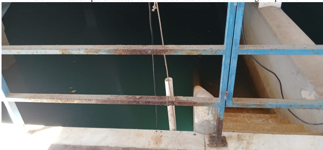
Foto 12 –Guarda corpo de proteção das células enferujado
