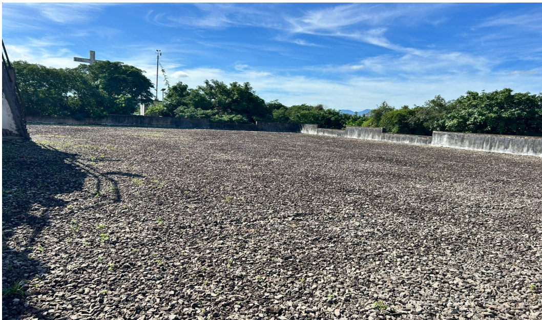
Foto 14 –Parte superior do reservatório bem preservada
