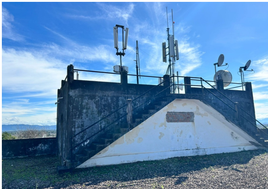
Foto 15 – Estruturas instaladas na parte superior do reservatório e pára-raio
