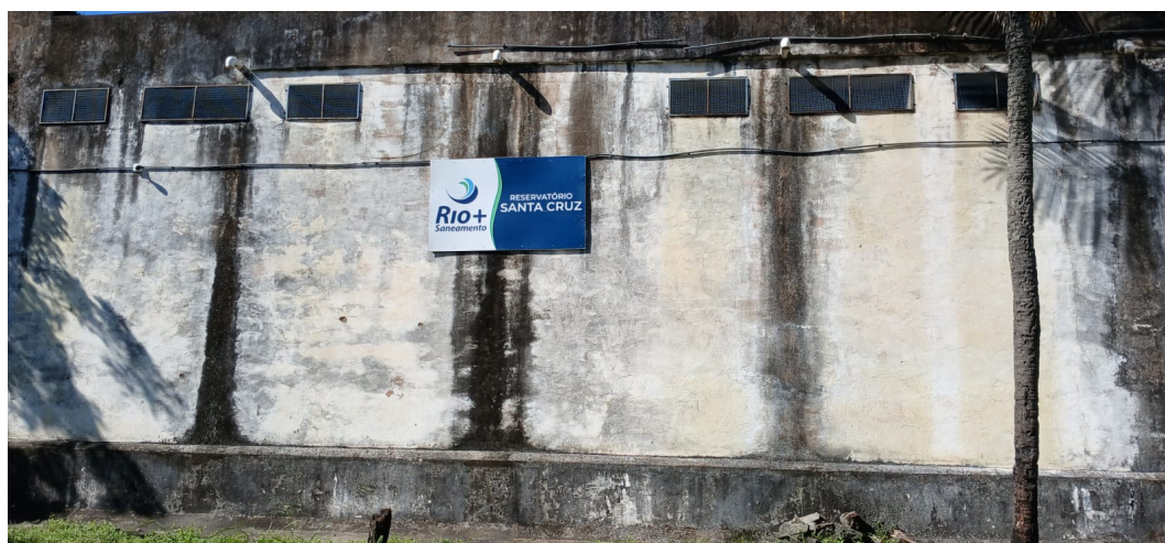
Foto 01 – Identificação do reservatório
