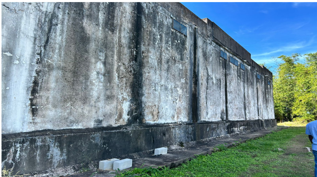
Foto 08 – Proteção das aberturas externas do reservatório
