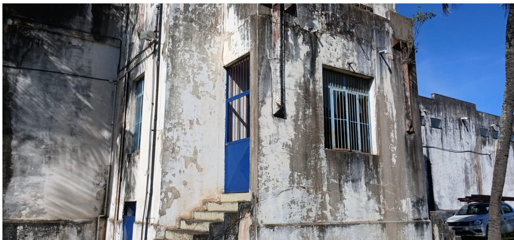
Foto 02 – Entrada do reservatório
