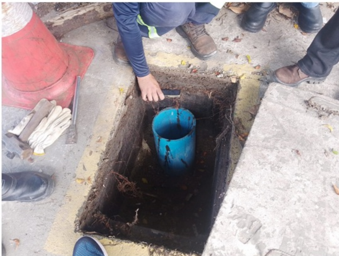
Foto 3 –Pintura desgastada em volta de uma das válvulas
