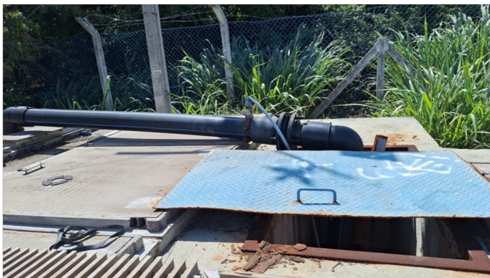
Fotos 5– Nova montagem do recalque ( agora Pead) da bomba (agora submersível) passando por fora da caixa ( by-pass).
