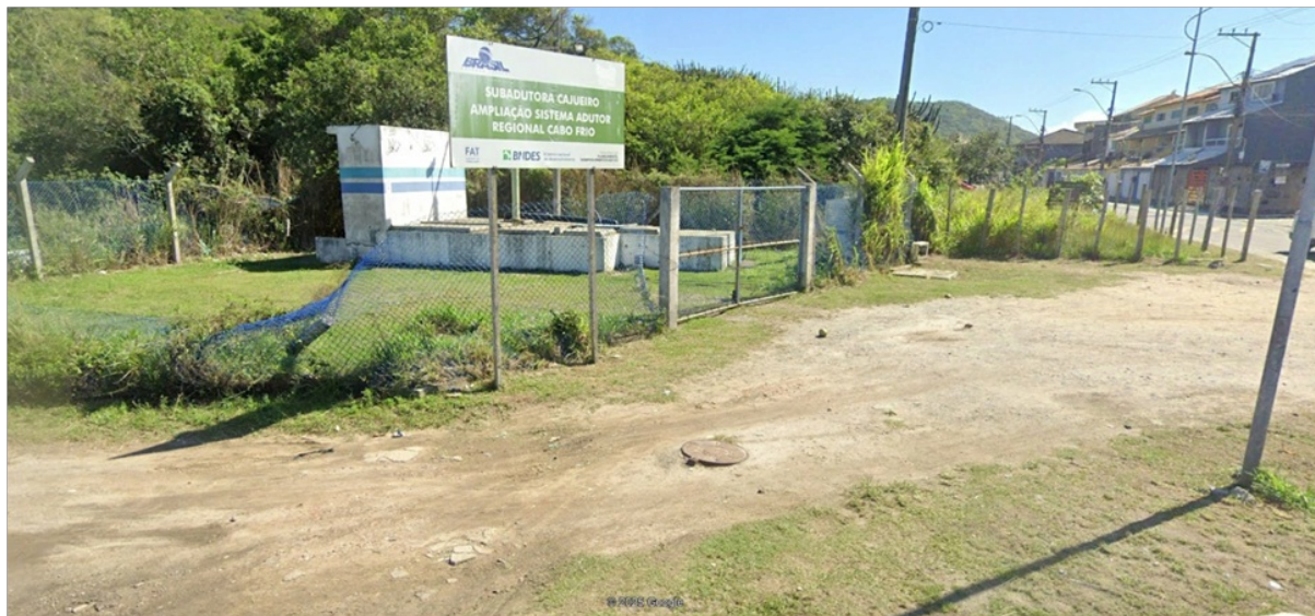
Foto 2 – Vista da EEE .
