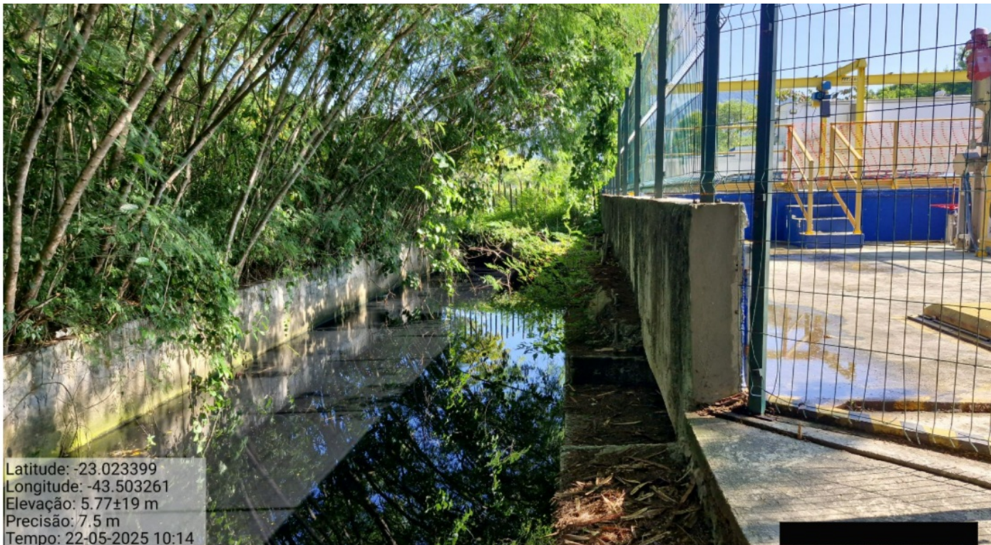
Foto 19 - Canal de Drenagem Pluvial
