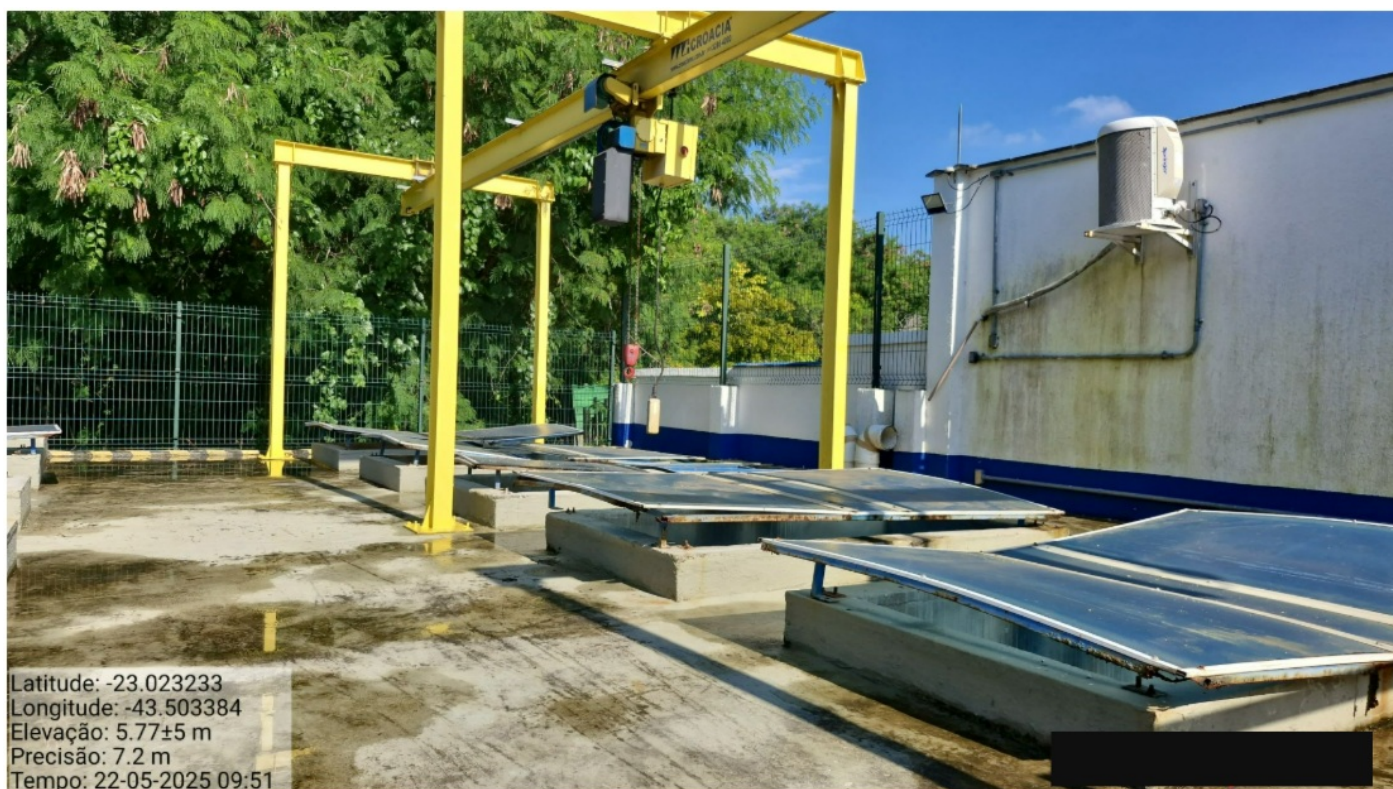
Foto 12 - área para manutenção do barrilete de recalque e sala de bombas
