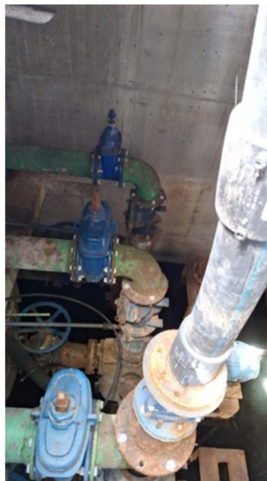
Foto 3 e 4 – Poço com bomba submersível; Barrilete com uma bomba auto-escorvante, porém segundo a Concessionária está na reserva.
