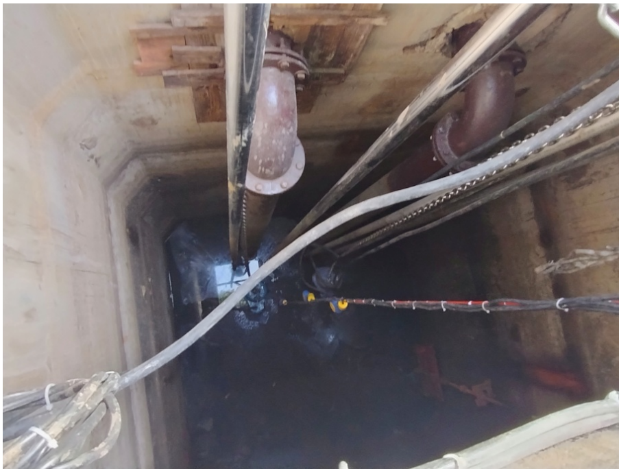
Foto 36: Bombas submersíveis
