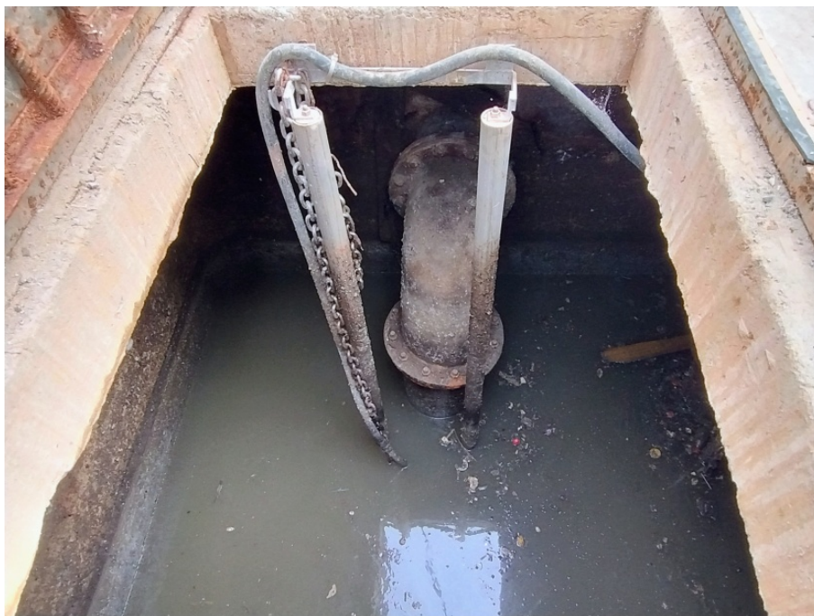
Foto 32: Bomba submersível
