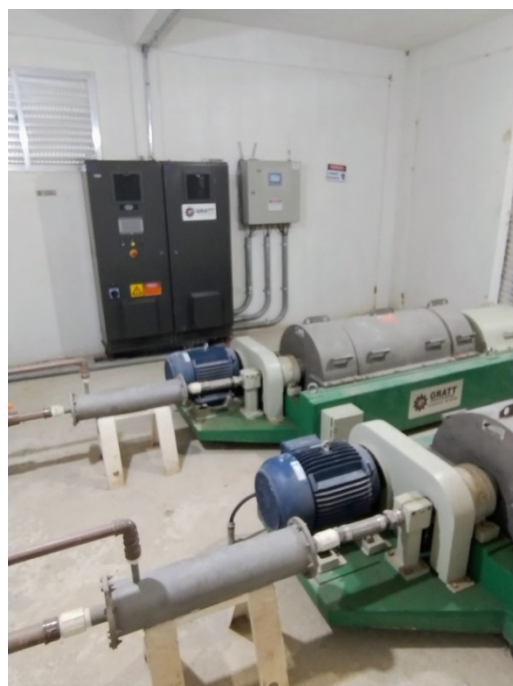
Foto 11: Casa de máquinas das centrífugas
