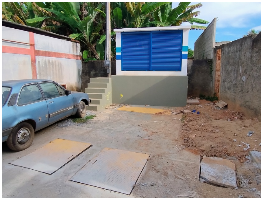
Foto 29: Estação elevatória de esgoto bruto (C)
