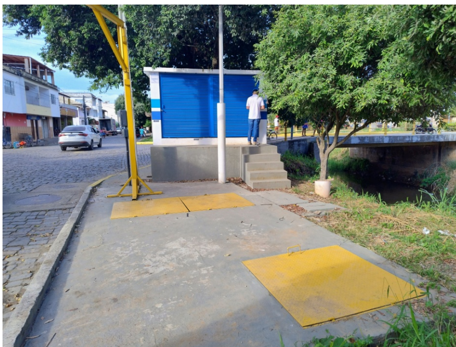
Foto 34: Estação elevatória de esgoto bruto (B)
