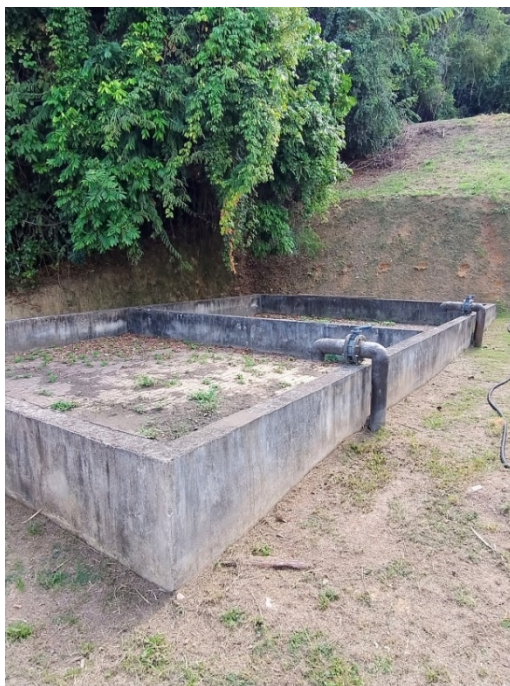
Foto 09: Tanque de secaquem de lodo
