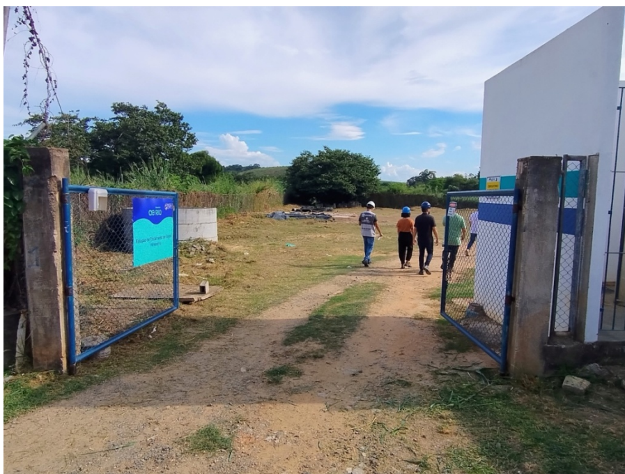
Foto 01: Entrada da ETE
