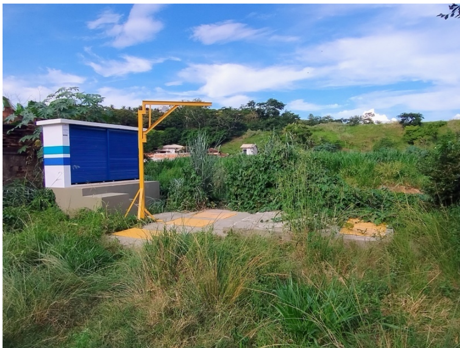
Foto 24: Estação elevatória de esgoto bruto (F)
