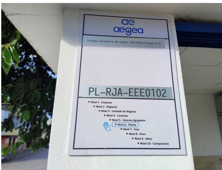
Foto 35: Placa identificação EEE (B)
