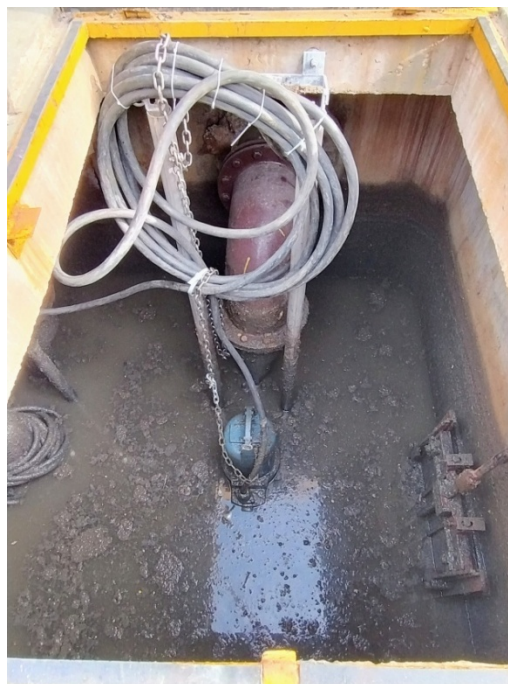
Foto 27: Bomba submersível
