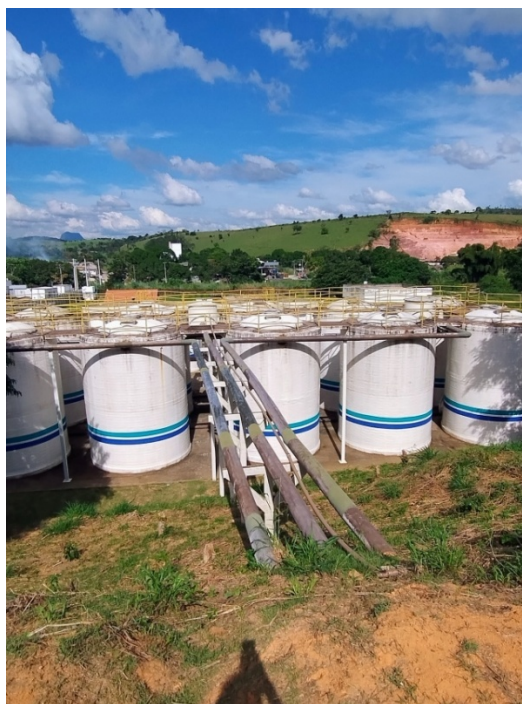
Foto 07: Reatores UASB RAFA
