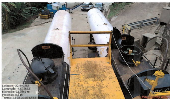
Foto 20: Tanques móveis de armazenamento de cloro (20 toneladas cada).
