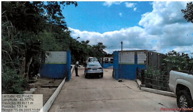
Foto 7: Entrada da UT Ribeirão das Lajes (ausência de placa de identificação da ETA).
