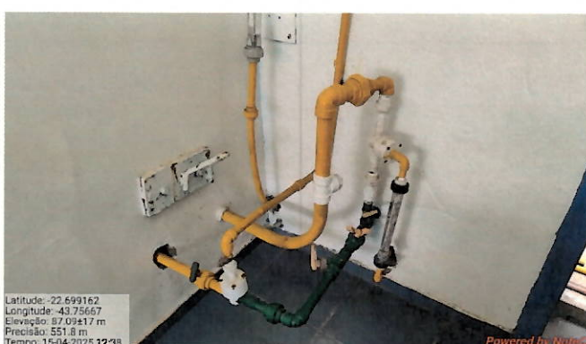
Foto 12: Medidores de Ácido Fluossilícico e o Ortopolifosfato de Sódio.
