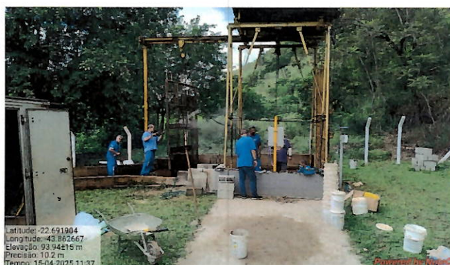
Foto 2: Estrutura de gradeamento.
