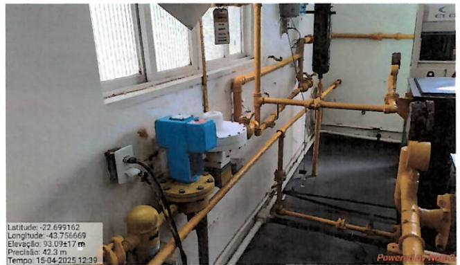
Foto 14: tubulações em bom estado de conservação.
