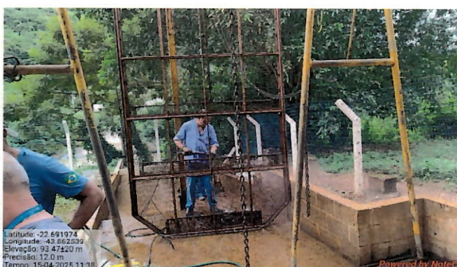
Foto 4: Limpeza manual da grade.
