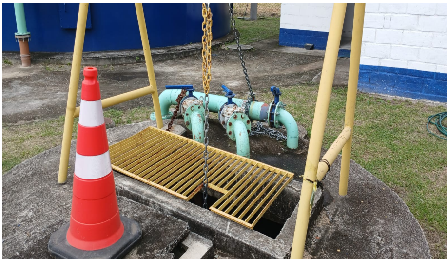
Foto 9 – Poço onde localiza-se a EEEB
