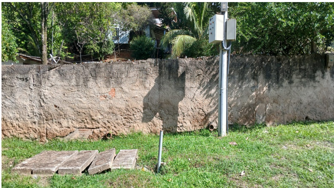
Foto 1 – Visualização da EEAT Santa Sofia, sem identificação
