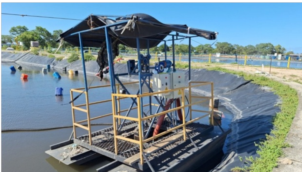
Foto 10 – Lagoa de decantação, onde estava sendo dragado o lodo.
