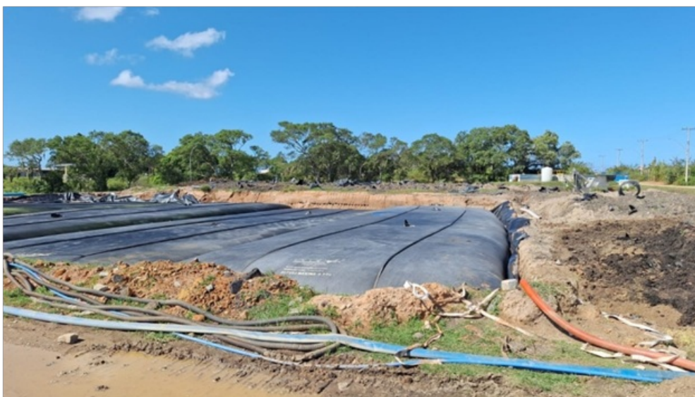
Foto 11 – Bag para armazenamento e drenagem do lodo dragado da lagoa.
