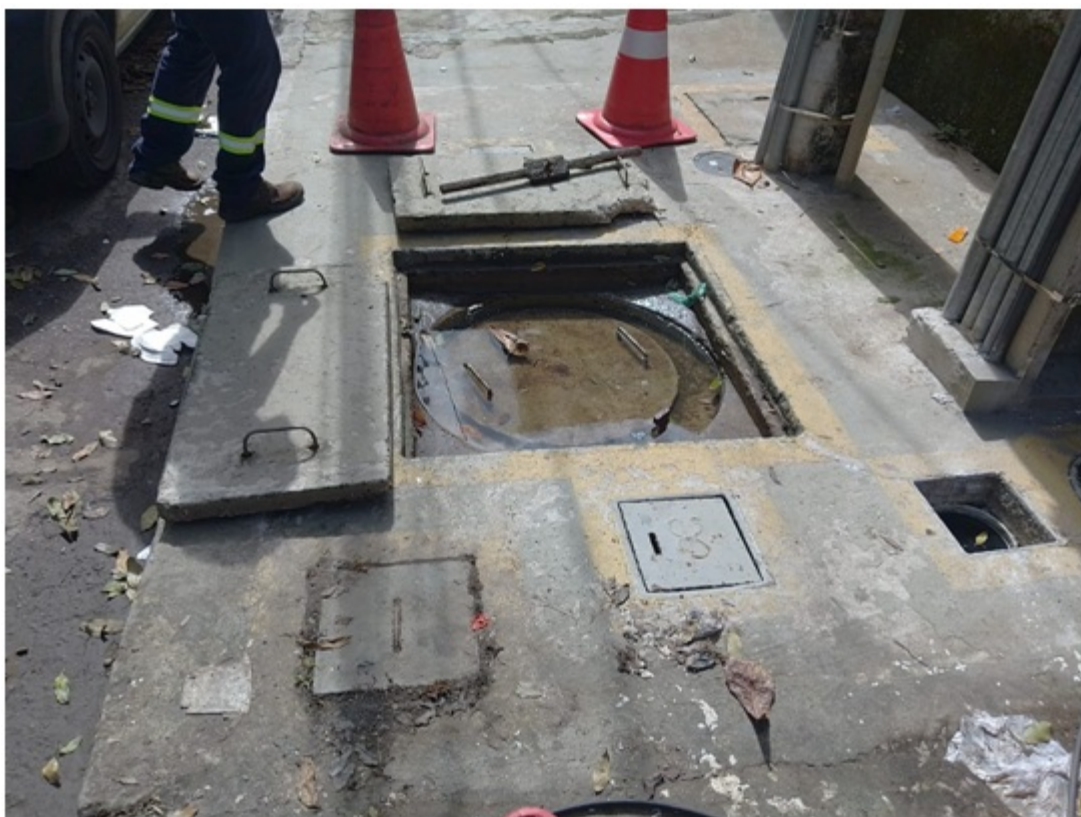
Foto 5 – Tampas de concreto do abrigo
