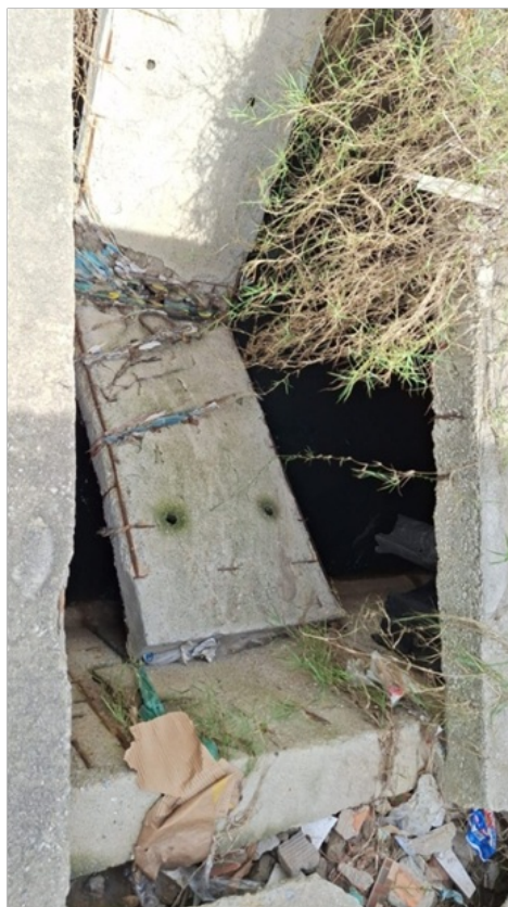
Foto 7 – Vista da captação do canal, onde não há uma barragem e sim uma sucção..
