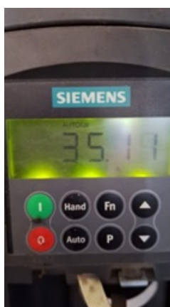
Foto 3, 4, 5 - Quadro elétrico com telemetria, proteção e inversor de frequência.
