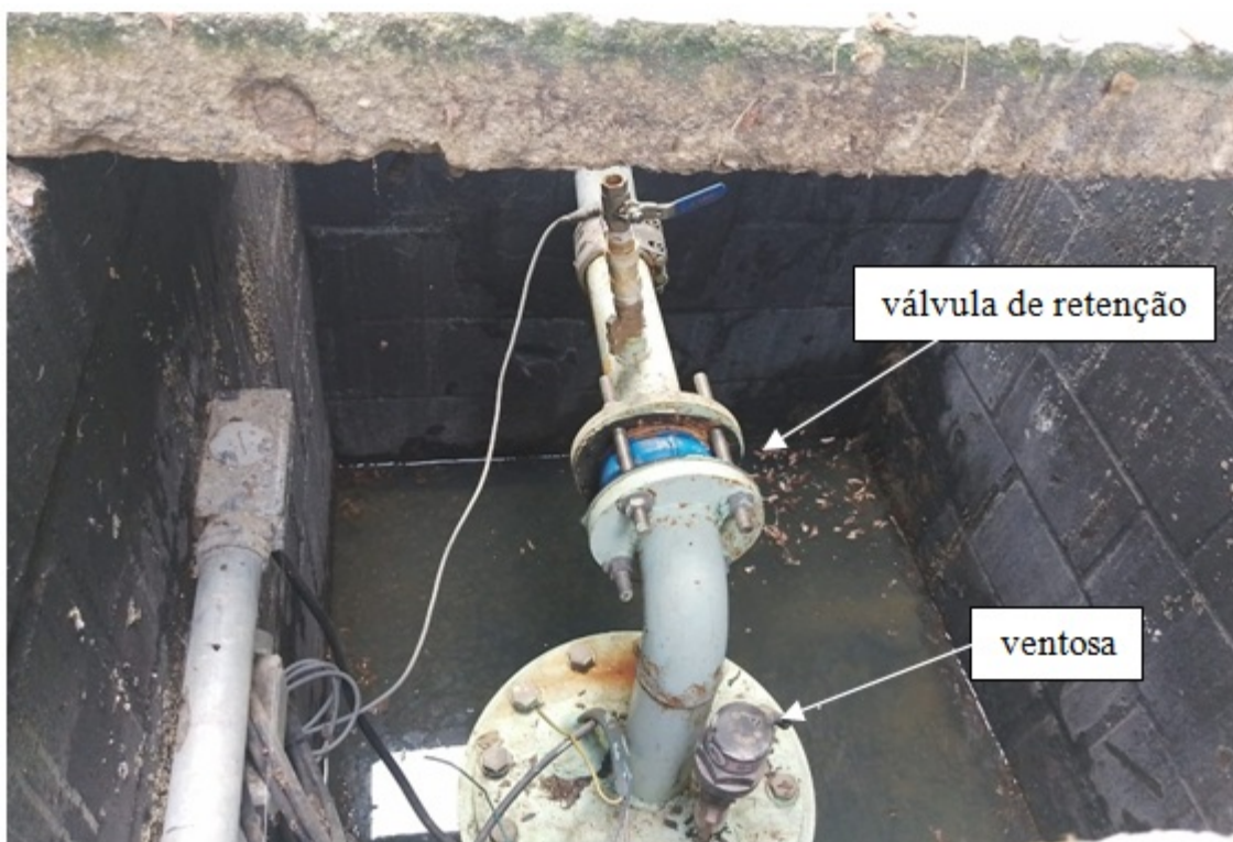
Foto 6 – Válvula de retenção e ventosa
