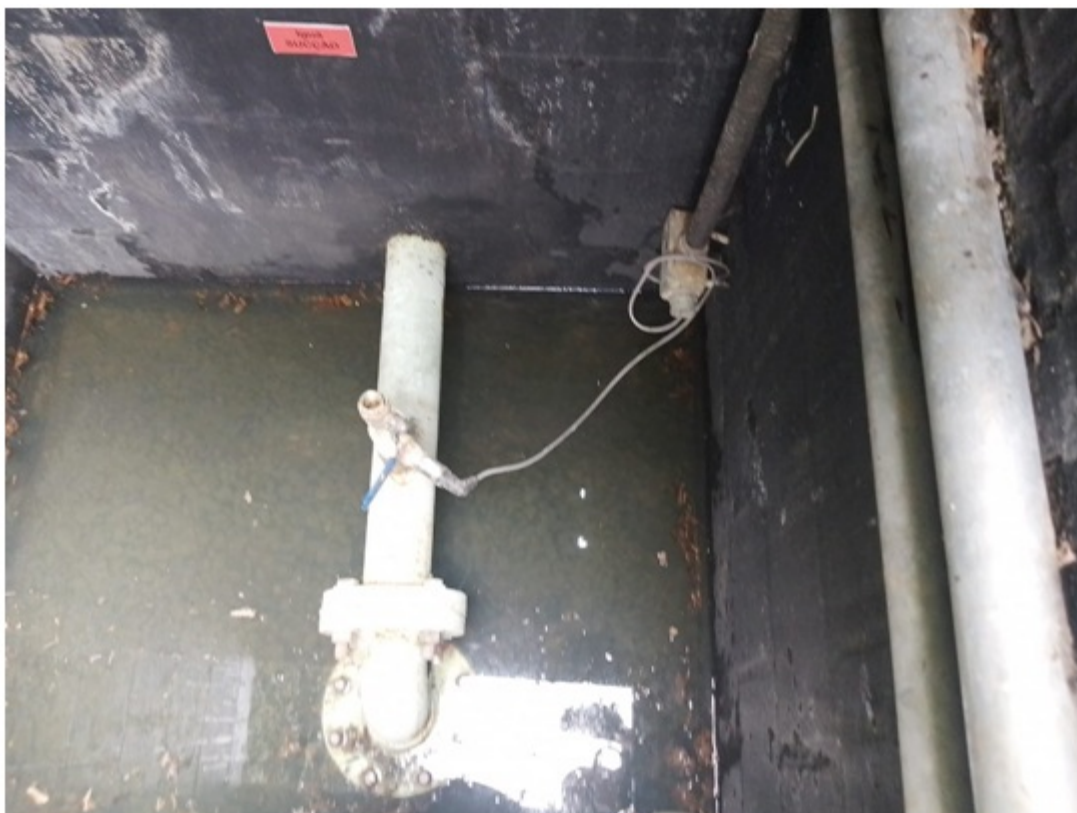
Foto 2 – Abrigo subterrâneo em bom estado de conservação
