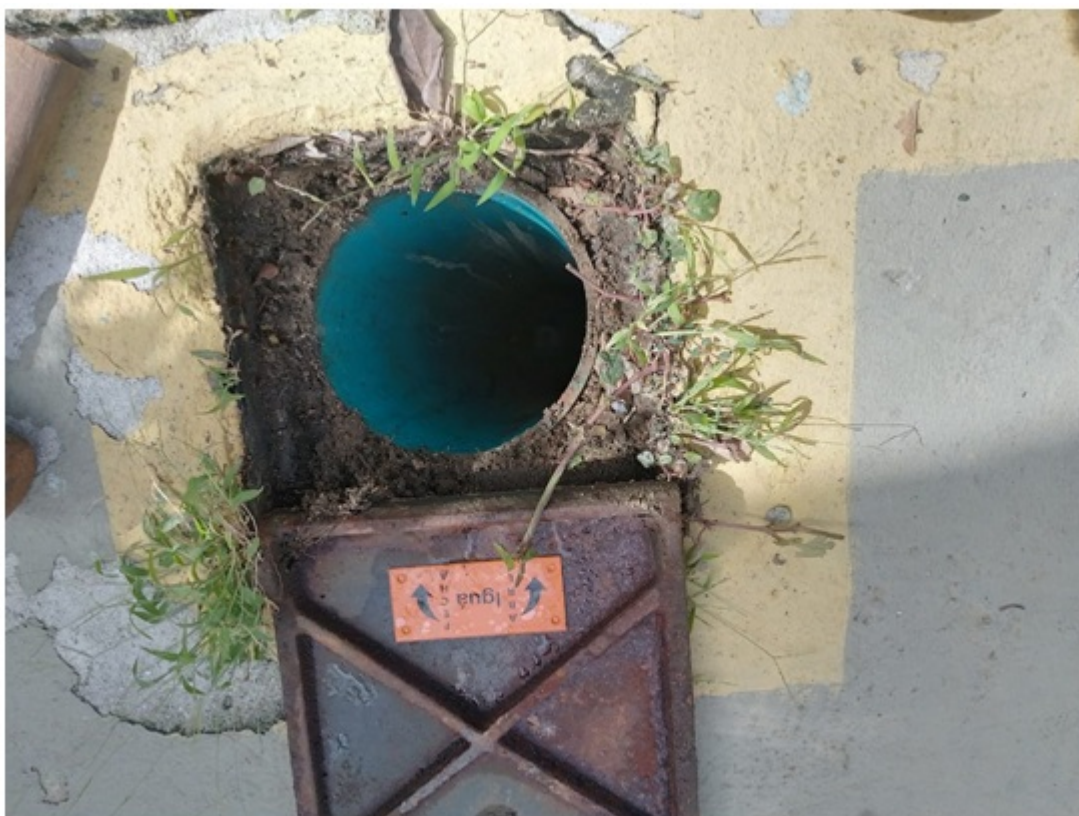
Foto 14 – Válvula na tubulação de bypass
