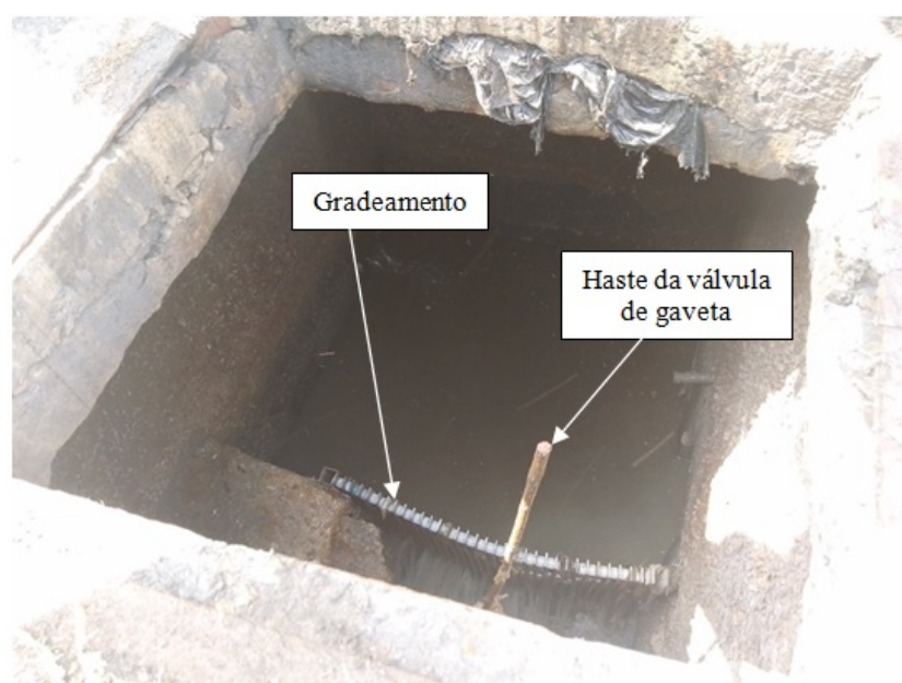
Foto 7 – Poço da chagada do esgoto
