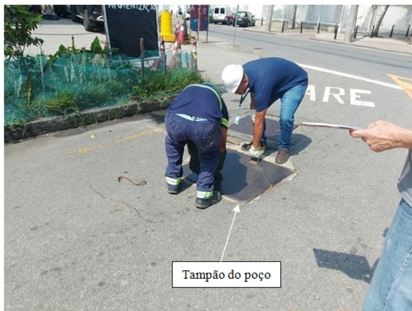
Foto 7 – Poço da chagada do esgoto
