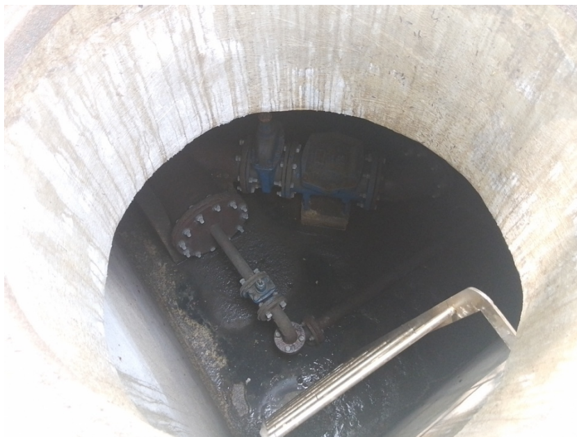
Foto 15 - Entrada da caixa da tubulação de recalque
