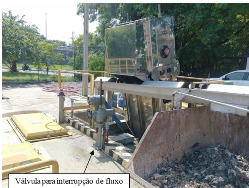
Foto 13 – Gradeamento mecânico com válvula para interrupção do fluxo
