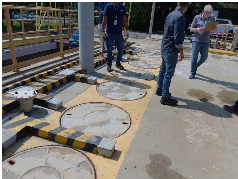
Foto 20 – Visitas do poço de sucção
