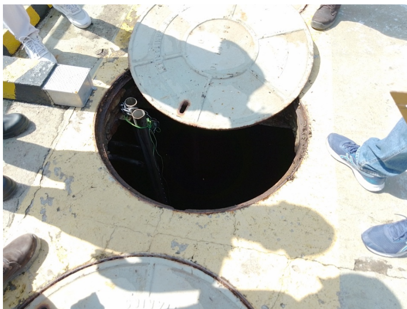
Foto 21 – Uma das visitas do poço de sucção
