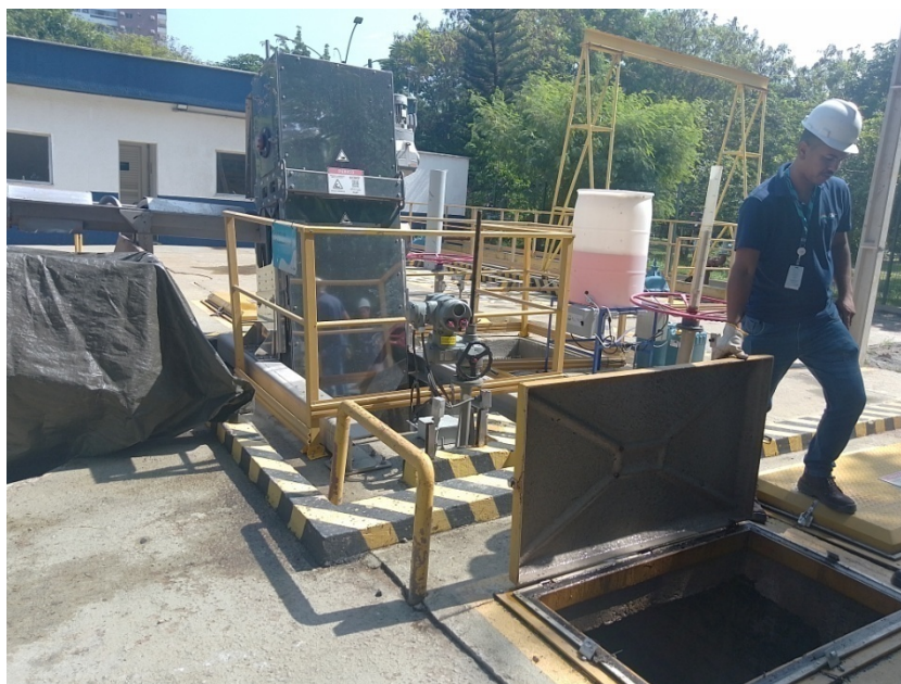
Foto 9 – Visita da caixa receptora do esgoto
