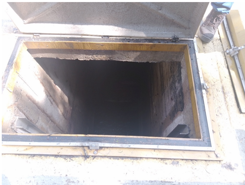
Foto 10 – Visita da caixa receptora do esgoto
