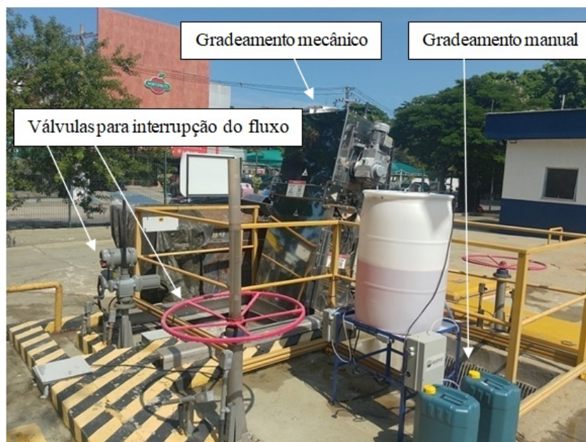
Foto 11 – Gradeamento mecânico e manual
