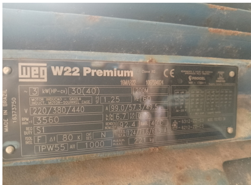
Foto 9 – Plaqueta das informações elétricas da motobomba
