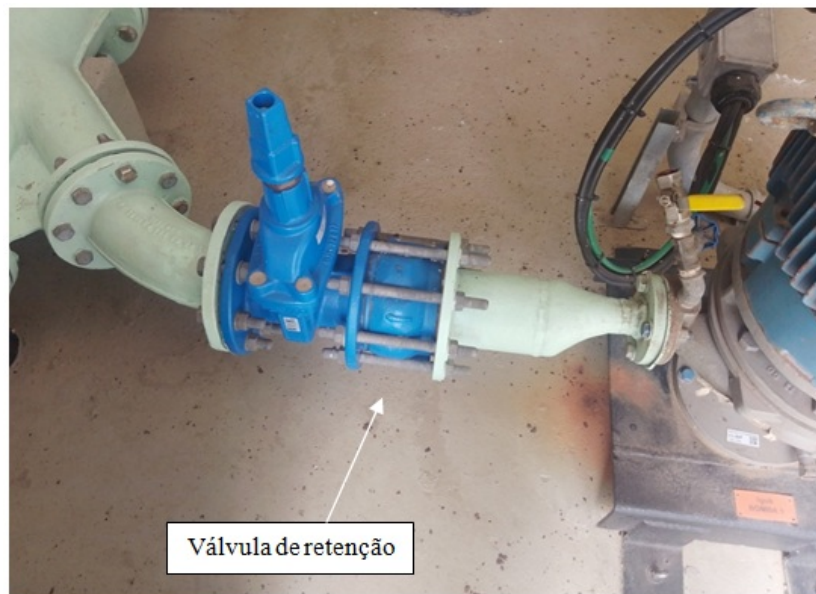
Foto 11 – Válvulas de retenção
