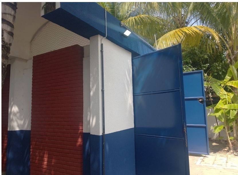
Foto 3 – Abrigo externo da elevatória
