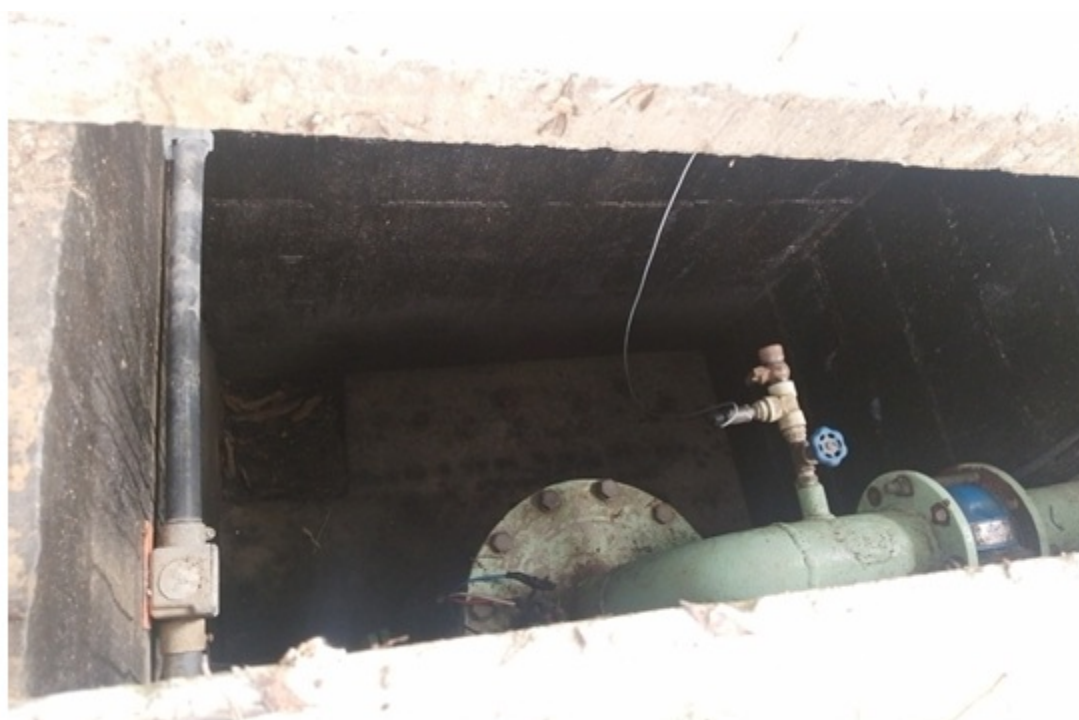
Foto 10 – Abrigo sem acúmulo de água
