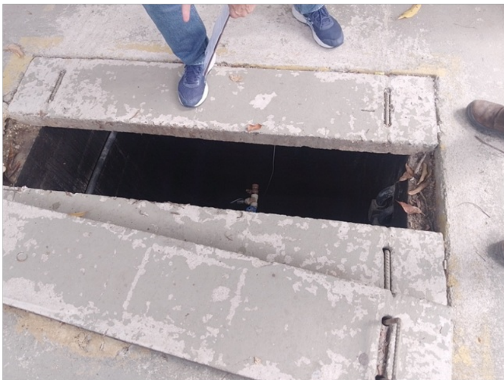
Foto 3 – Tampas do abrigo
