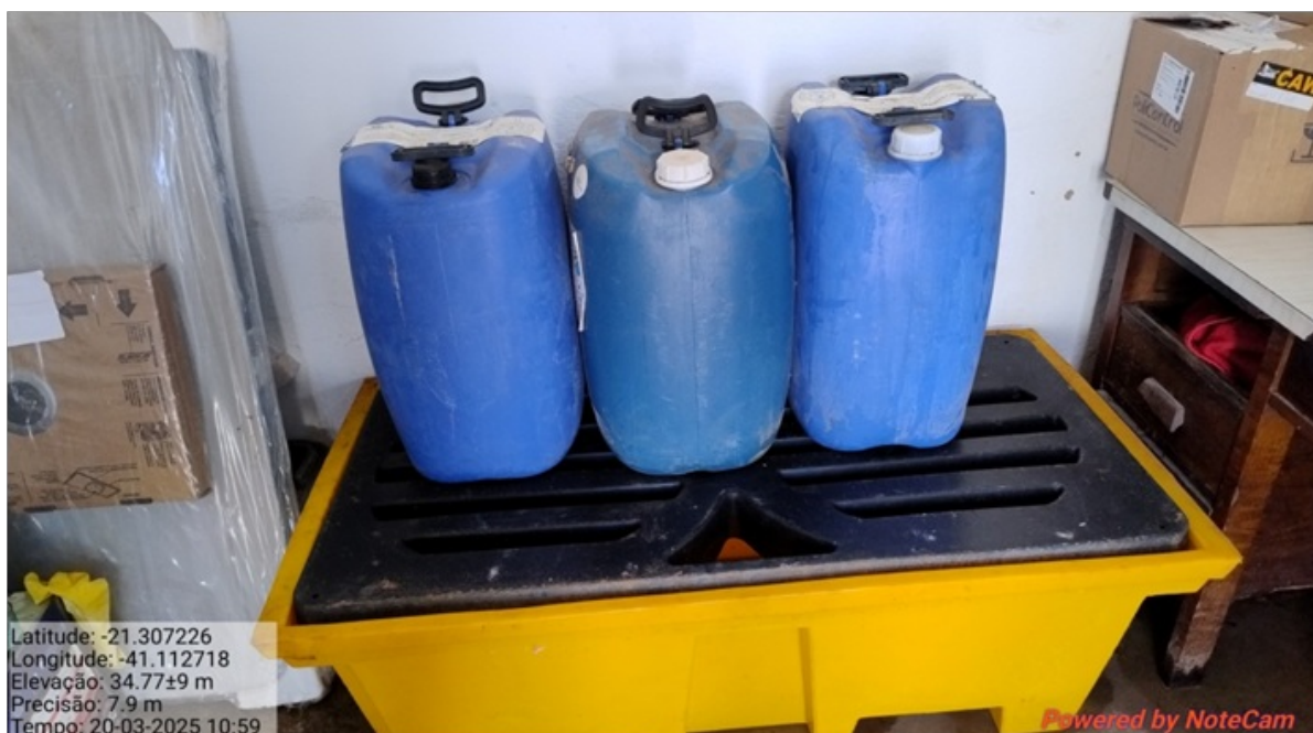
Foto 9 - armazenamento de sulfato de alumínio
