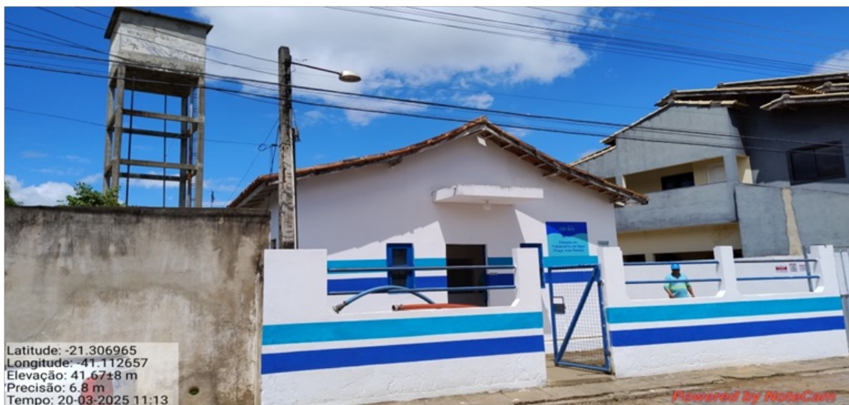
Foto 1- Entrada principal da Estação de Tratamento
