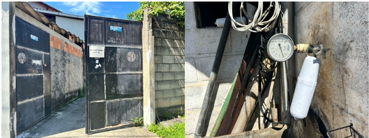
Foto 5 e 6 – Medição de pressão no imóvel no lote 01
