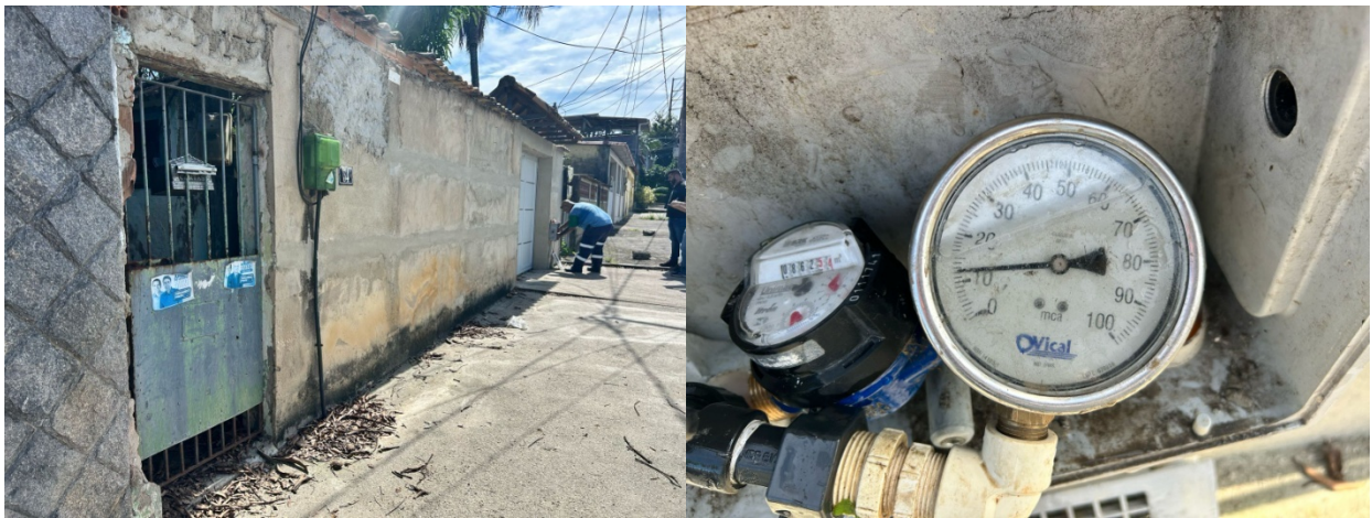
Foto 1 e 2 – Medição de pressão no imóvel nº 34
