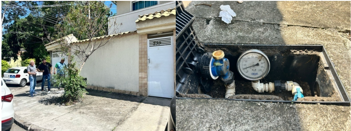
Foto 3 e 4 – Medição de pressão no imóvel nº 399
