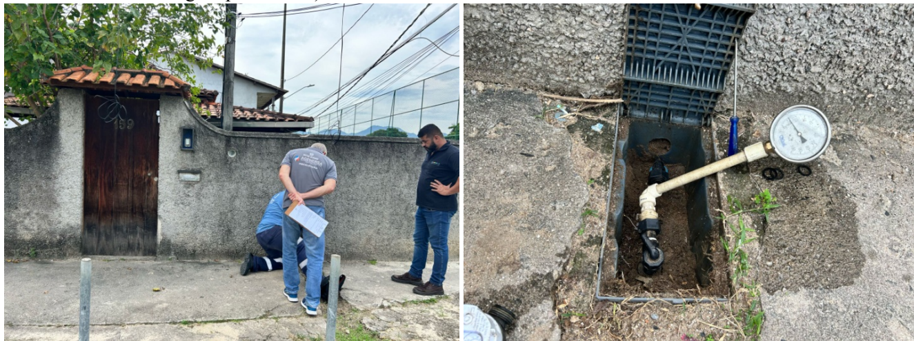
Foto 3 e 4 – Medição de pressão no imóvel nº 159
