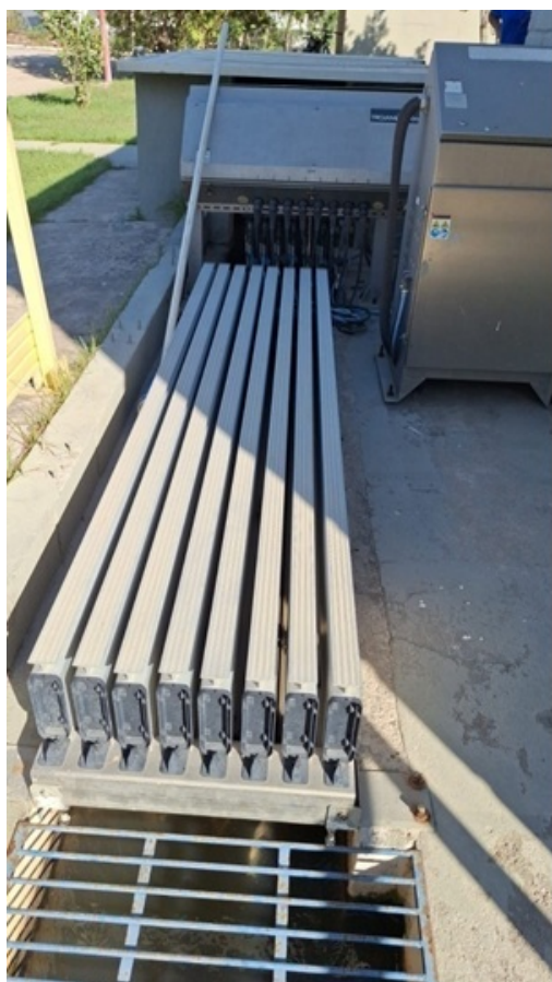
Fotos 13, 14 e 15 – Decantador secundário que raspa parte do lodo e envia para centrífuga ; Centrífuga que desidrata o lodo para transporte ao aterro sanitário; Unidade UV que faz a desinfecção do esgoto tratado.
