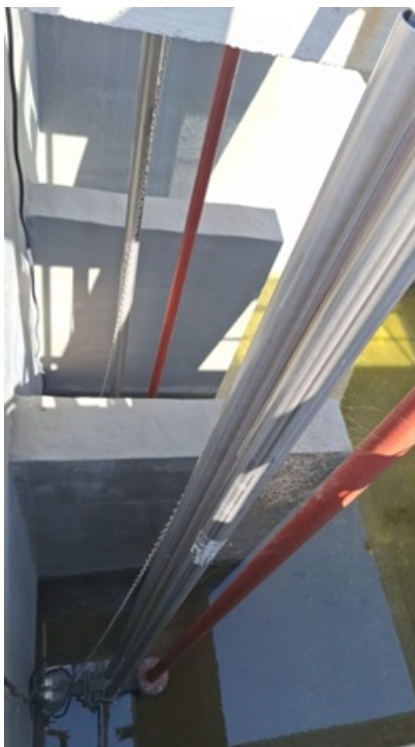
Foto 6 e 7 – Adensamento de lodo primário ( sistema novo implantado durante a construção da nova ETE).
