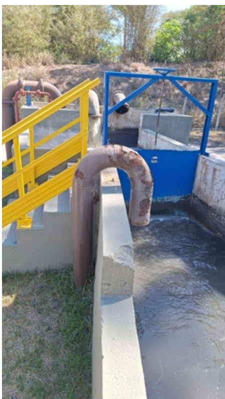
Foto 4 e 5 – Chegada do esgoto no desarenador, e posterior passagem pelo gradeamento mecanizado, o qual já foram instalados novos na construção da nova ETE , assim o tratamento preliminar é comum as duas ETE's.
