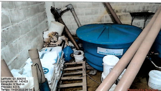
Foto 102: Armazenamento de produtos químicos.
