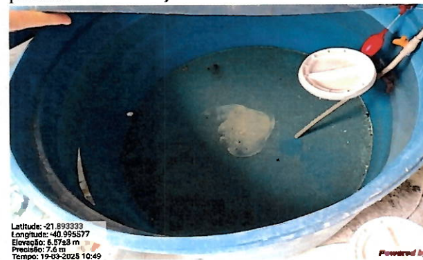
Foto 110: tanque de diluição de ortopolifosfato.
