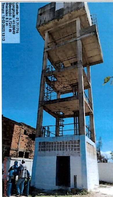
Foto 55: Vista externa do reservatório.
