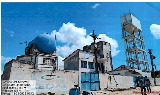
Foto 5: Entrada da ETA São João da Barra (identificação apagada e pouco legível).
