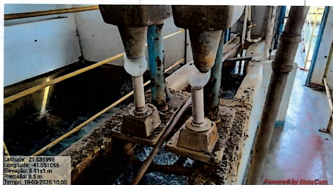
Foto 14: Adição de coagulante (sulfato de alumínio).
