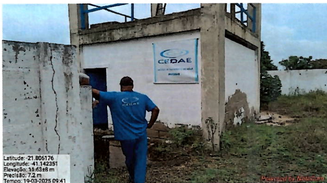
Foto 98: Entrada da UT Pipeiras/Palacete.
