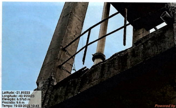
Foto 113: guarda-corpo danificado.
