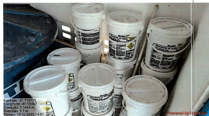
Foto 92: Armazenamento de hipoclorito de cálcio.
