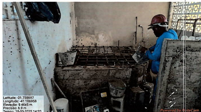
Foto 78: Leito de produtos químicos em reforma.
