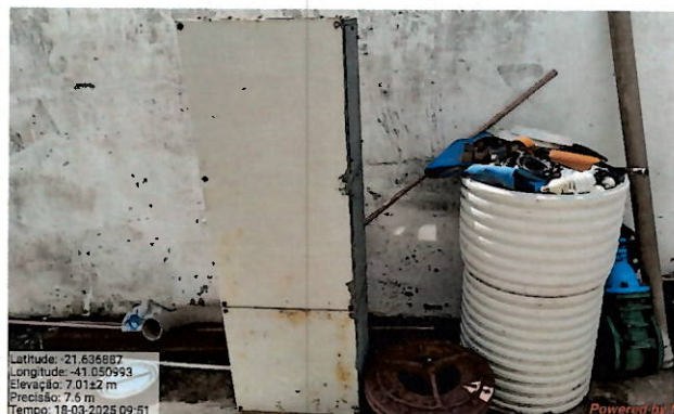
Foto 12: Materiais e bens inservíveis armazenados de maneira inadequada.
