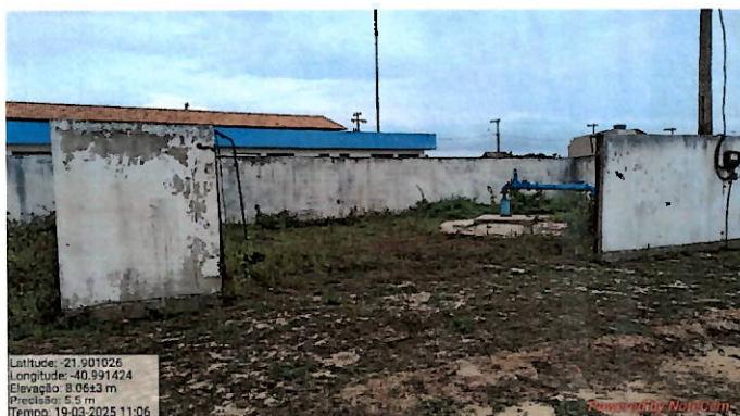
Foto 114: Entrada da UT Barra do Açu II.
