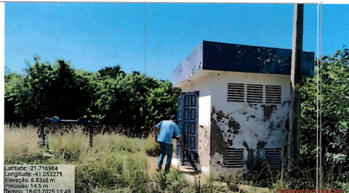
Foto 60: Poço, à esquerda, e prédio de abrigo do sistema de tratamento, à direita.
