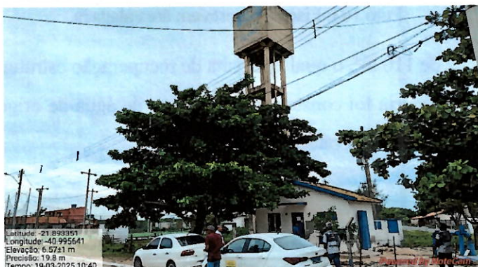
Foto 105: Entrada da UT Barra do Açu I.
