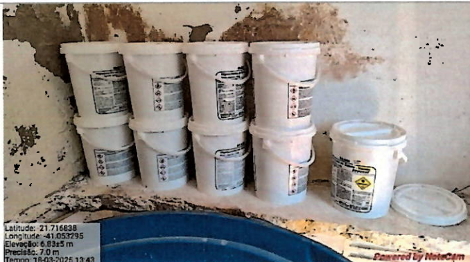
Foto 65: Armazenamento de hipoclorito de cálcio.
