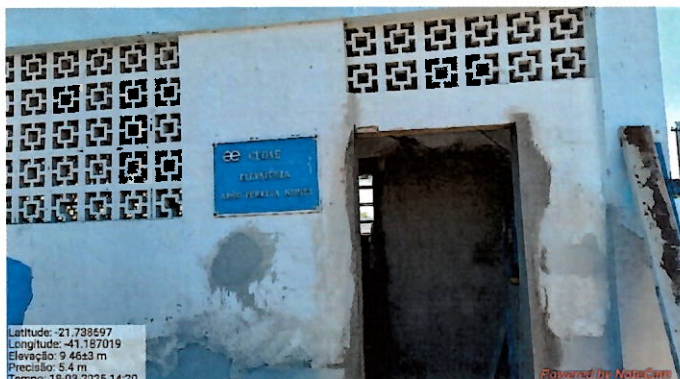
Foto 77: Edificação em reforma.
