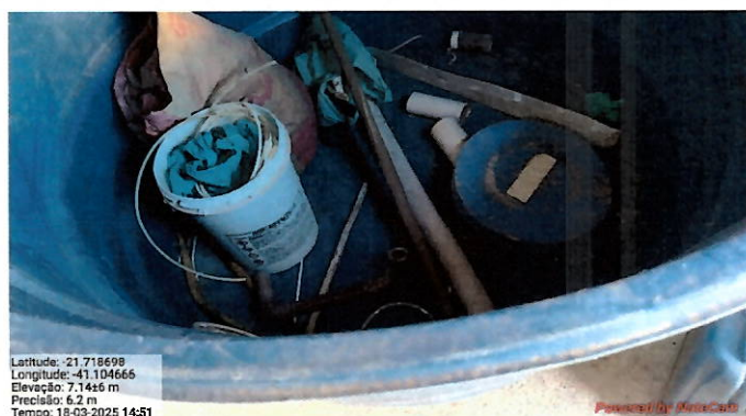
Foto 91: Tanque e diluição de ortopolifosfato fora de operação.
