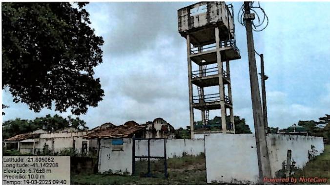
Foto 96: Entrada da UT Pipeiras/Palacete.
