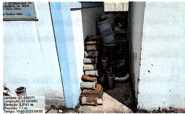
Foto 10: Materiais e bens inservíveis armazenados de maneira inadequada.
