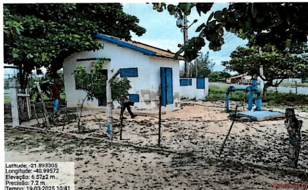
Foto 106: Ausência de cercamento adequado.
