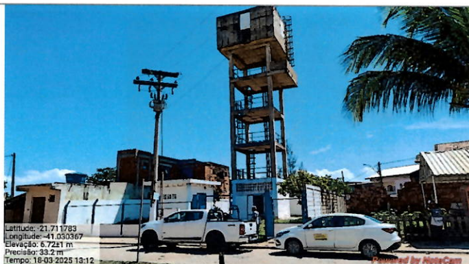
Foto 51: UT Ilha (ausência de placa de identificação).
