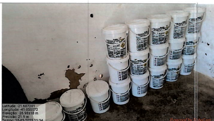
Foto 45: Armazenamento de hipoclorito de cálcio.
