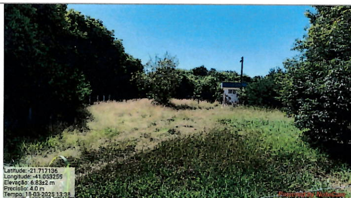
Foto 59: Entrada da UT Curva (ausência de cercamento adequado e placa de identificação).
