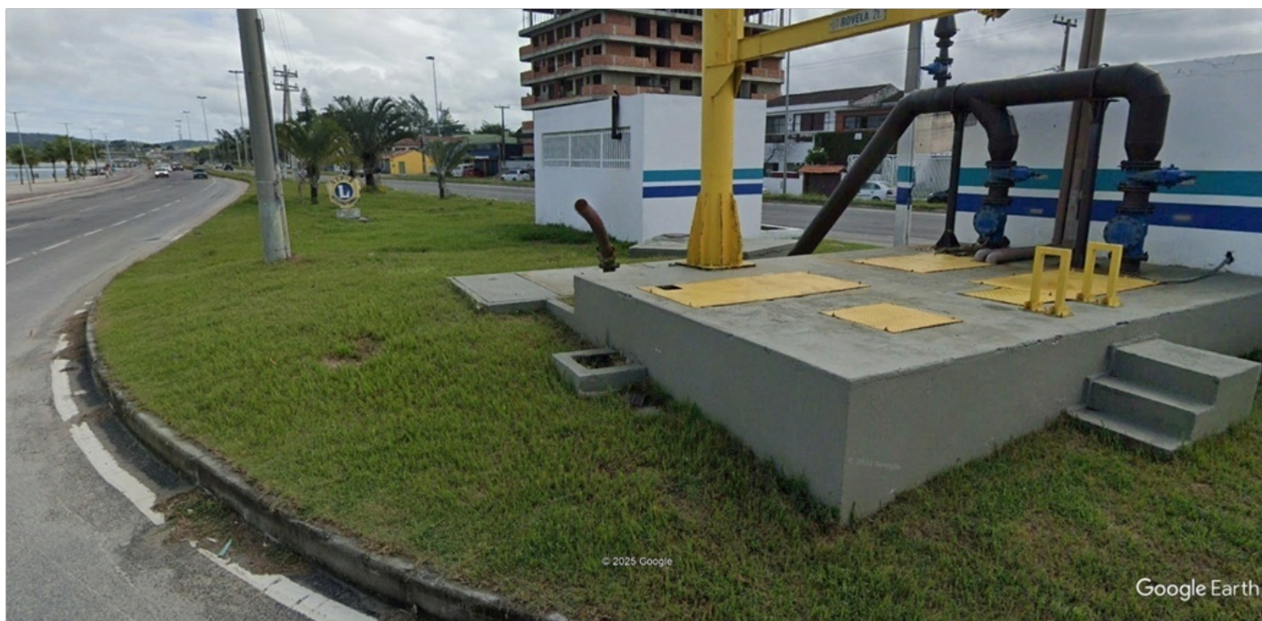
Foto 2 – Vista do abrigo do gerador, do poço das bombas, recalque da EEE Existente e monovia
