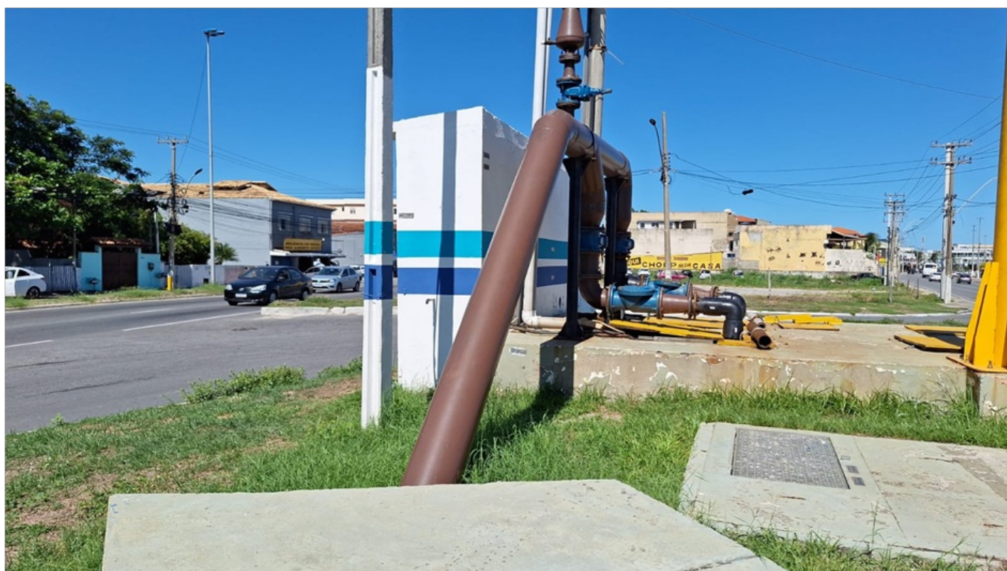
Foto 3 - Nova montagem mecânica para bombas submersíveis
