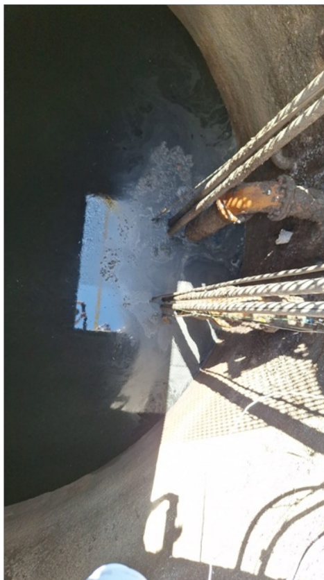
Foto 5 - Poço das bombas
