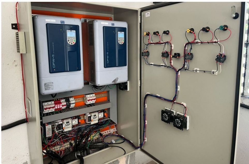
Foto 46 – Visualização interna do painel de automação
