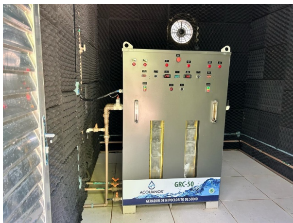
Fotos 15 e 16 - Sistema de produção do hipoclorito de sódio
