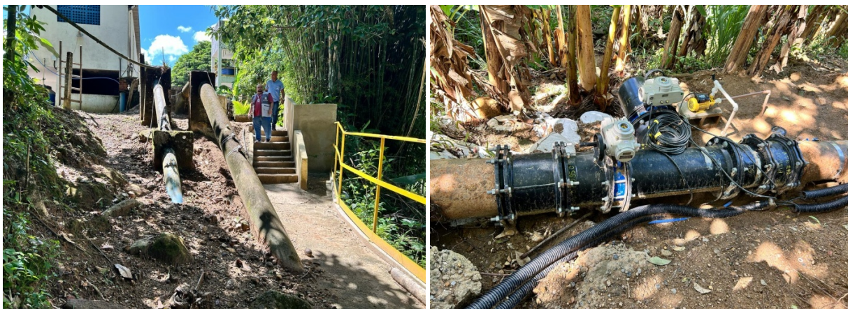
Fotos 11 e 12 – Adutoras de chegada com válvulas de vazão instaladas e o novo sistema de medição de turbidez sendo implantado
