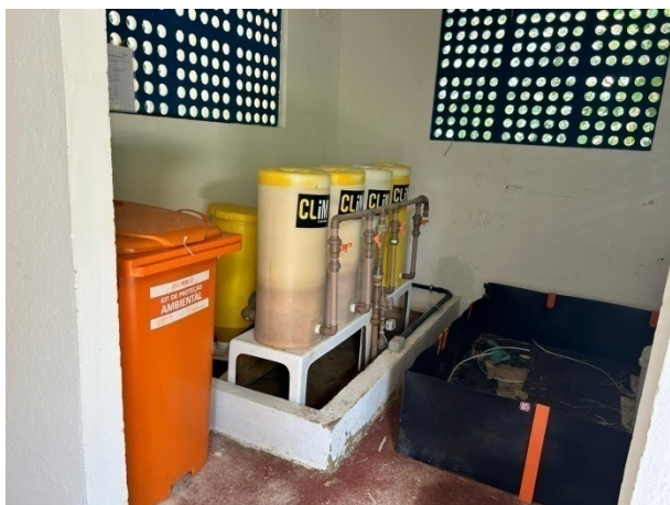
Fotos 17 e 18 - Sistema de aplicação do tricloro
