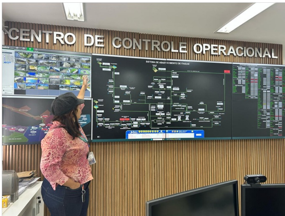
Foto 5 - Centro de Controle Operacional
