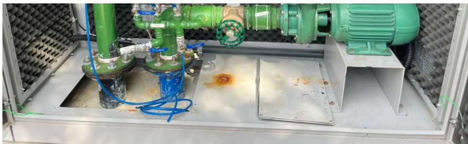
Foto 29 – Visualização interna da unidade e seus equipamentos
