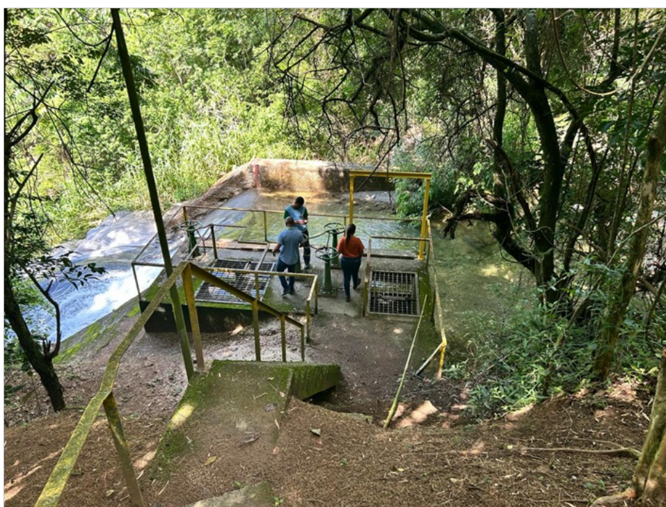
Foto 7 - Vista do acesso a captação a partir da escada que só possui guarda-corpo de um lado
