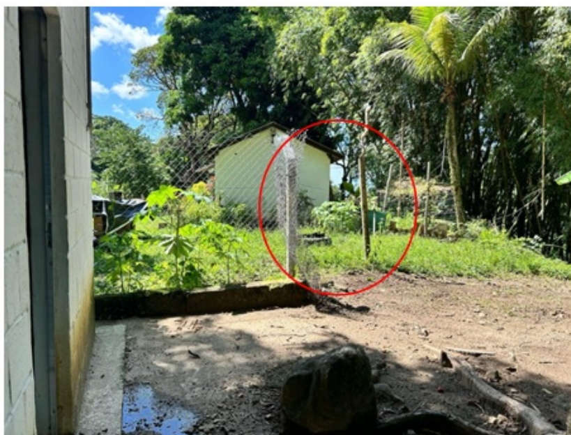
Foto 21 – Cerca da unidade com partes abertas
