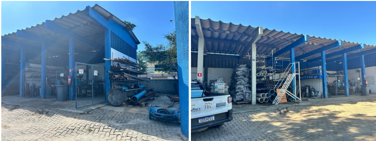
Foto 2 e 3 –Local de armazenamento dos materiais
