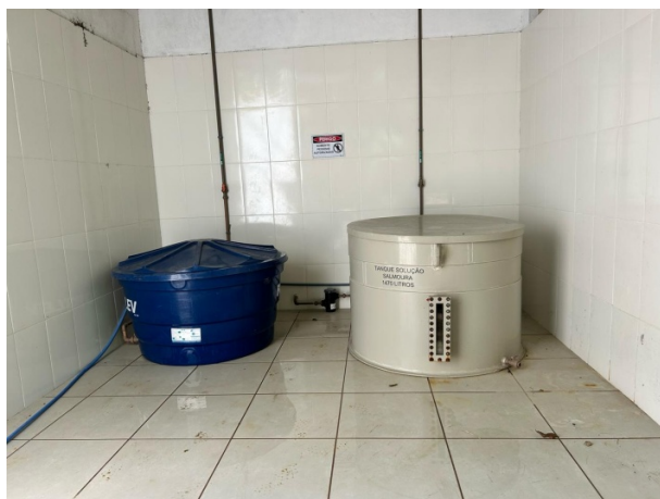
Fotos 15 e 16 - Sistema de produção do hipoclorito de sódio
