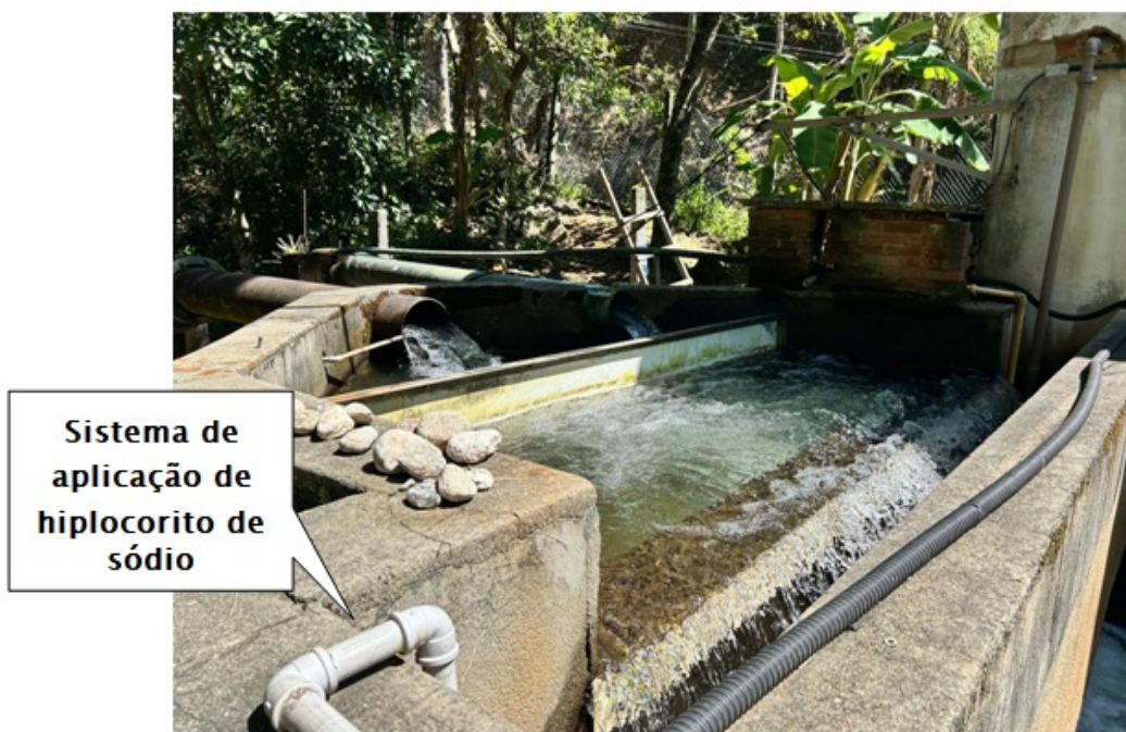
Foto 13– Captação de água no tanque de contato
