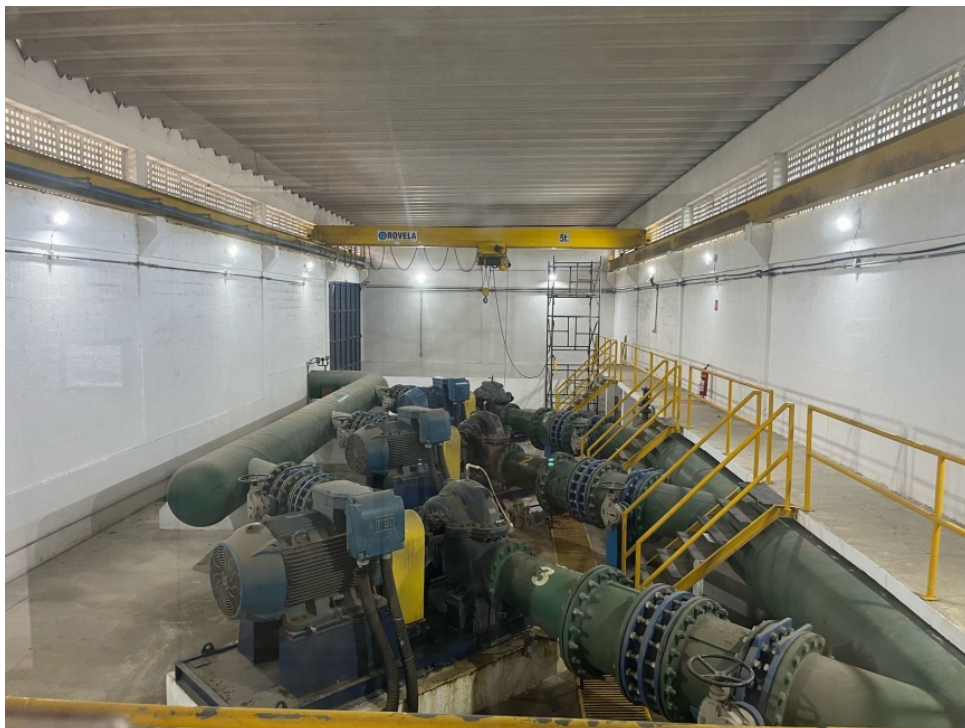
Foto 32 – Visualização interna dos conjuntos motobombas da unidade
