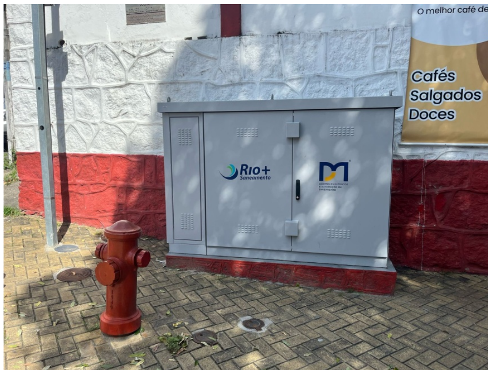
Foto 28 – Visualização da EEAT Cemitério do tipo container
