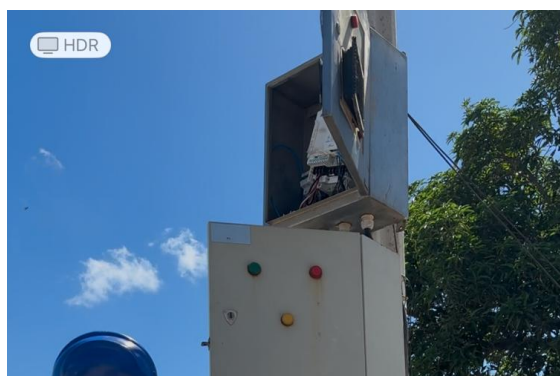
Foto 5 —Componentes Elétricos da EEE São Pedro 2 no poste do padrão
