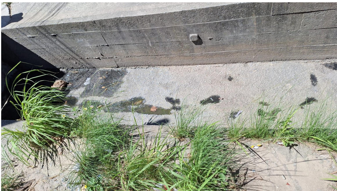
Foto 12 – Canal vazio em 03/04/2025, sem extravasamento de efluente para a Laguna e após limpeza com caminhão Vac-All
