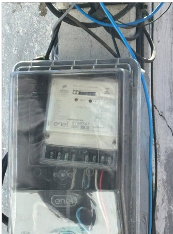
Foto 9 - Componente C – Medidor de consumo
