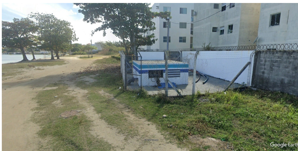
Foto 2 – Vista do abrigo da EEE Marina Clube , com portão e cerca protetora..
