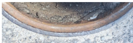
Foto 3 – Vista do PV na Rua Francisco Lopes 499 (Local 2)
