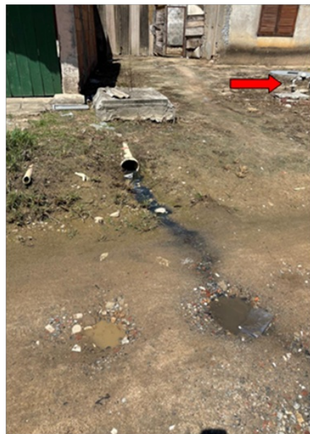
Foto 4 –Esgoto a céu aberto na Rua Carolina Lopes (Local 3). A seta vermelha aponta para o hidrômetro
