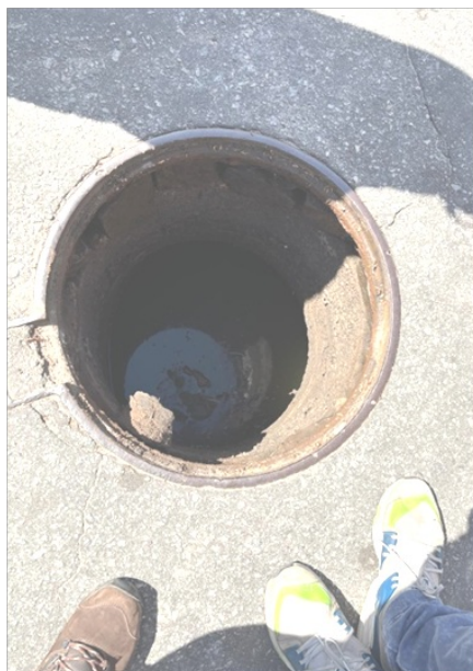
Foto 2 – Vista do poço de visita (PV) na Rua Hugo Francisconi (Local 1)
